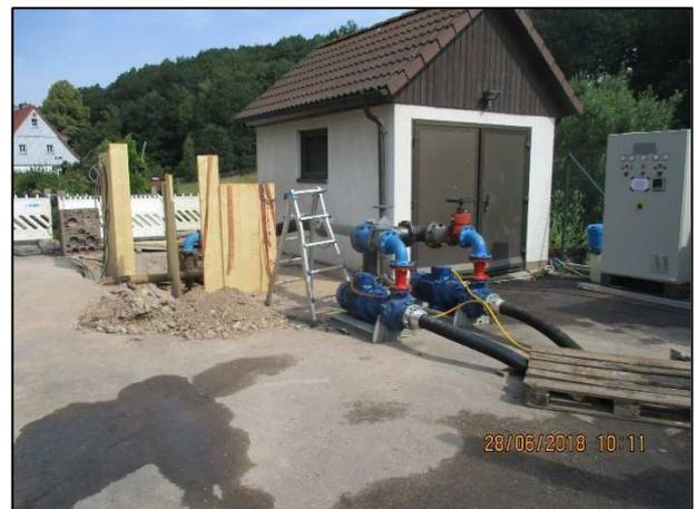
**Bild 5.2** Zugangsbereich mit bauzeitlicher Wasserhaltung
