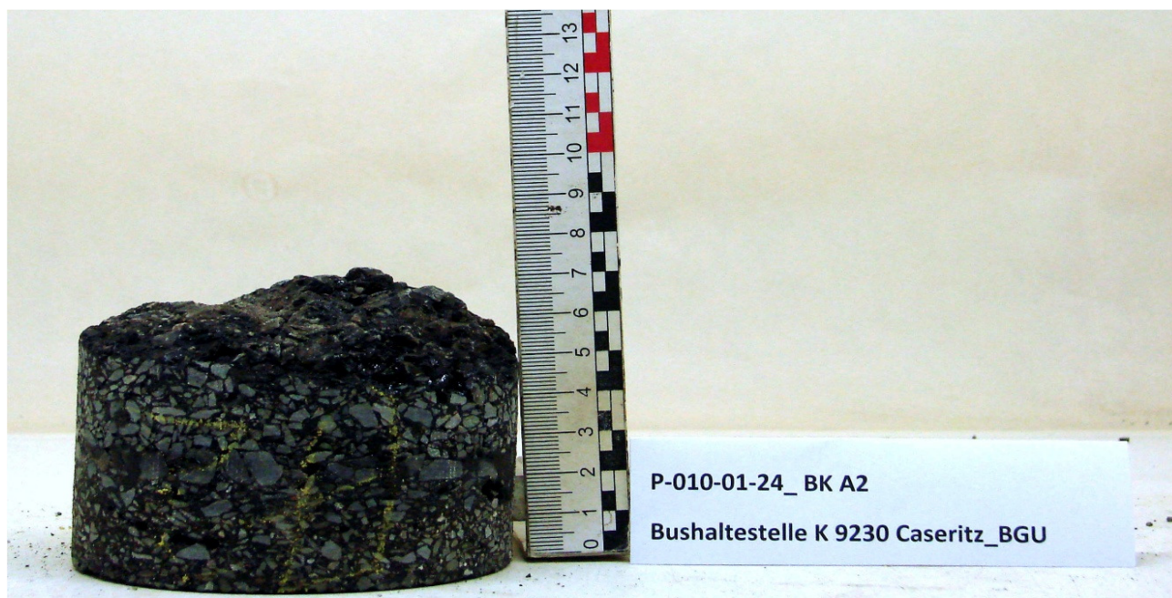
Oberkante im Foto an der Unterseite des Bohrkerns (Bohrkern steht auf dem Kopf!)
