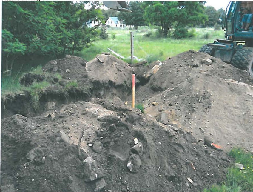
Abb. 2: Erdaushub Schurfgrube 1
