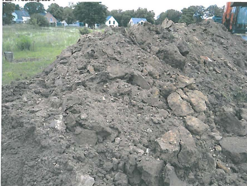
Abb. 2: Erdaushub Schurfgrube 4
