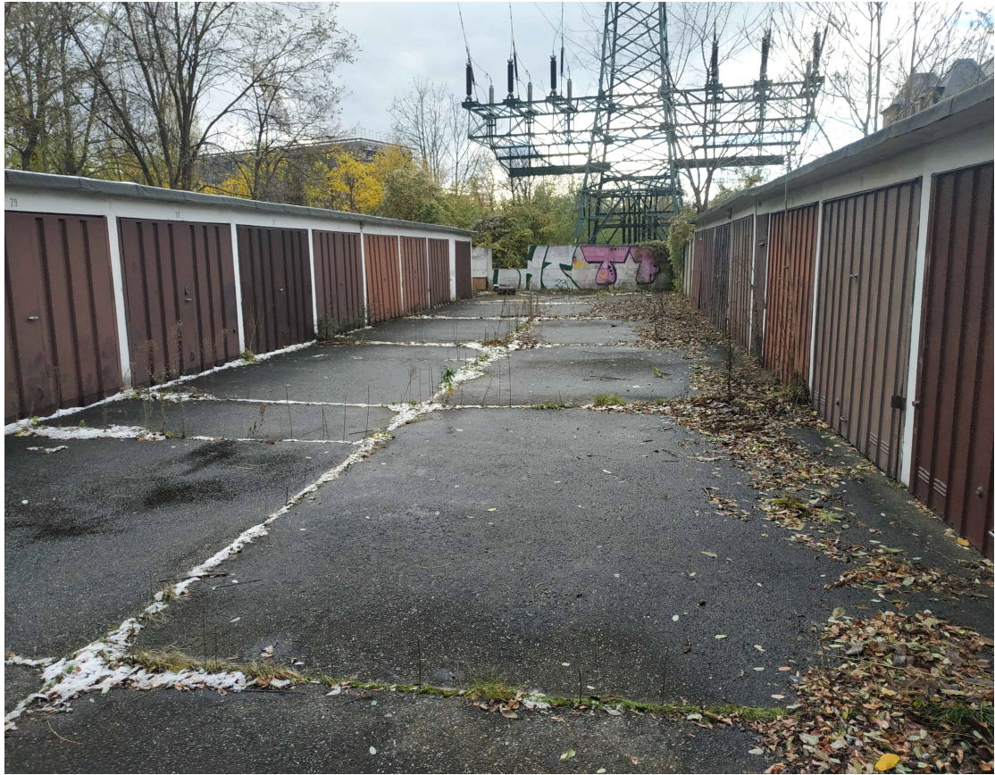
Abbruch Garagen, Ortbetonplatten, Zäune, Pfosten unterschiedlicher Bauart, Betonelemente und Maschendraht, Einfahrtstor, Schächte und Kanäle
