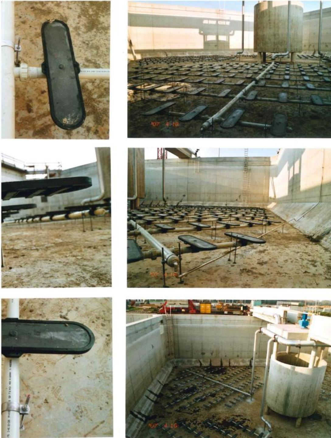
Abbildung 2: Fotodokumentation Belüfter 2007 während Erweiterung der KA
