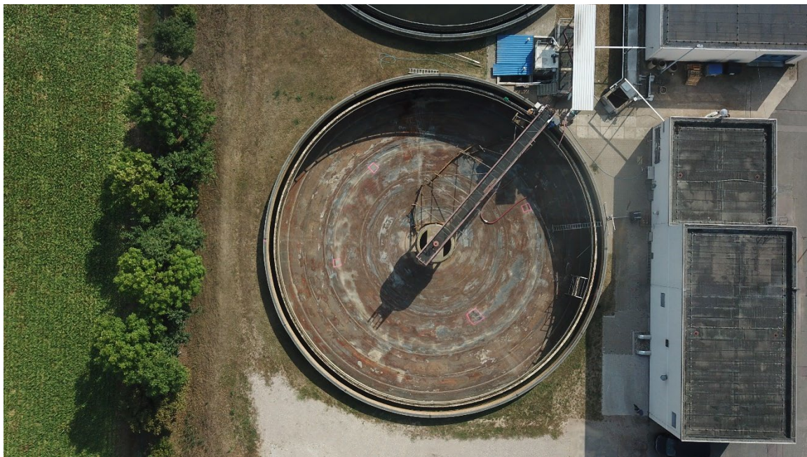
Draufsicht Nachklärbecken A - 110
