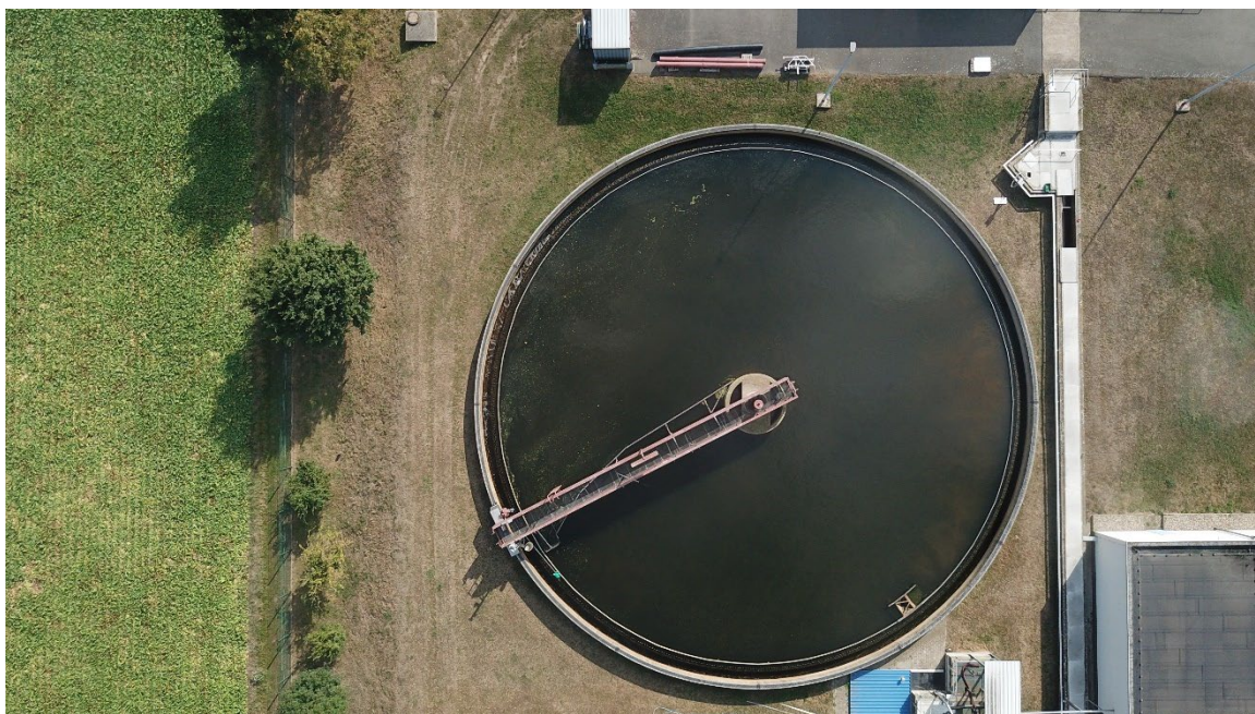
Draufsicht Nachklärbecken A -111
