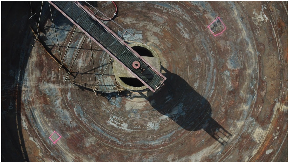
Draufsicht Nachklärbecken A - 110
