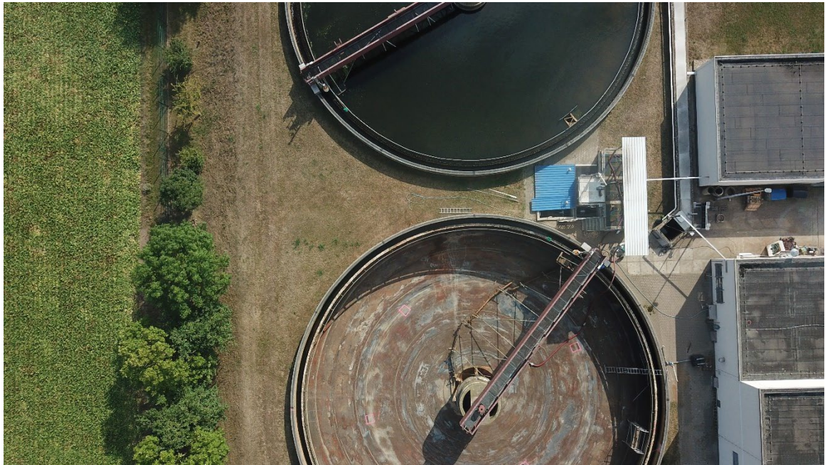
Rücklaufschlammumpwerk zwischen NKB A -110 und NKB A - 111 – Sanierung im 2. BA
