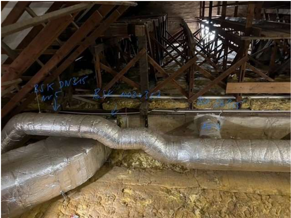
Foto 5 – Lage BSKs im DG Thünen-Haus
