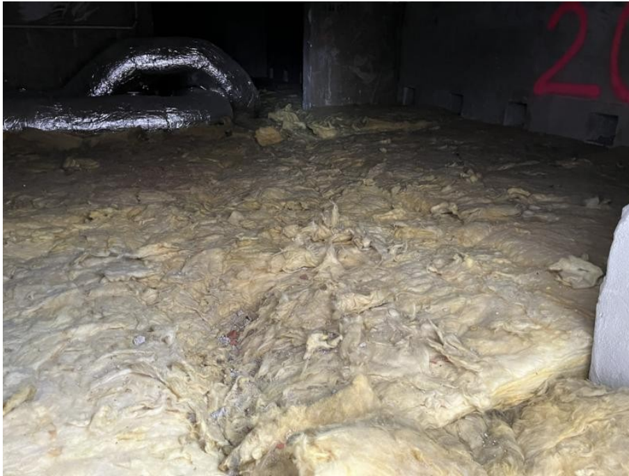
Nr. 35, Kriechgang links, Dämmung Fußboden
