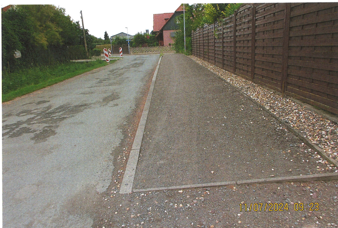
Schweg 2 - Rückbau geplant
