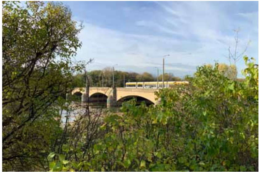
Blick von der Bastion (Mauer 2) auf die Zeppelinbrücke
