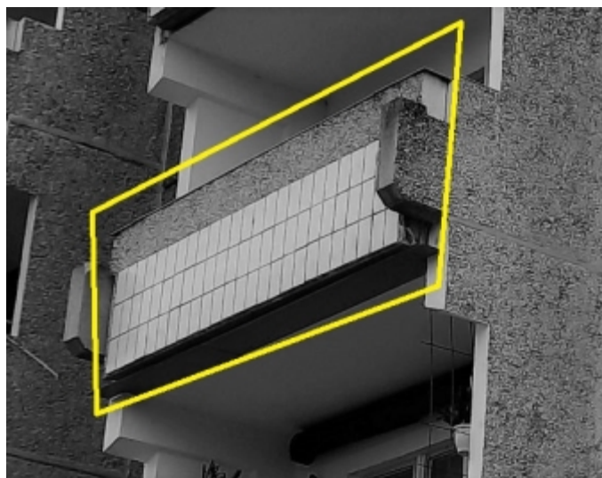
Bild: Bestands-Loggia Stb-Brüstung
