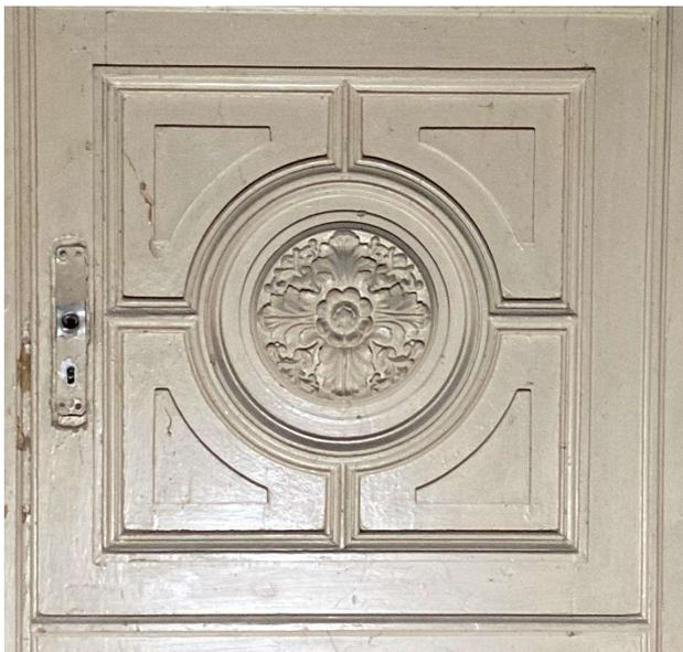
Abbildung: Vorbild für mittlere Füllung Türblatt 1-flg. Tür
