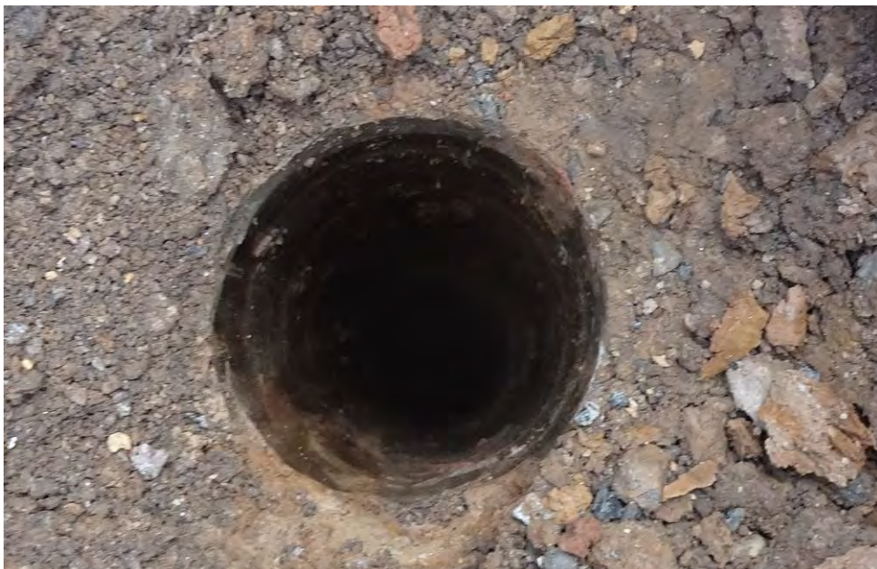
Bild 46: Entnahmestelle 12, Bohrkern BK 12, Schurf S 12, RKS 12 Ausbau der Mottelerstraße in Zwickau Station km 0+332, 3,5 m v. re. FBR, links Blick in Sondierstelle
