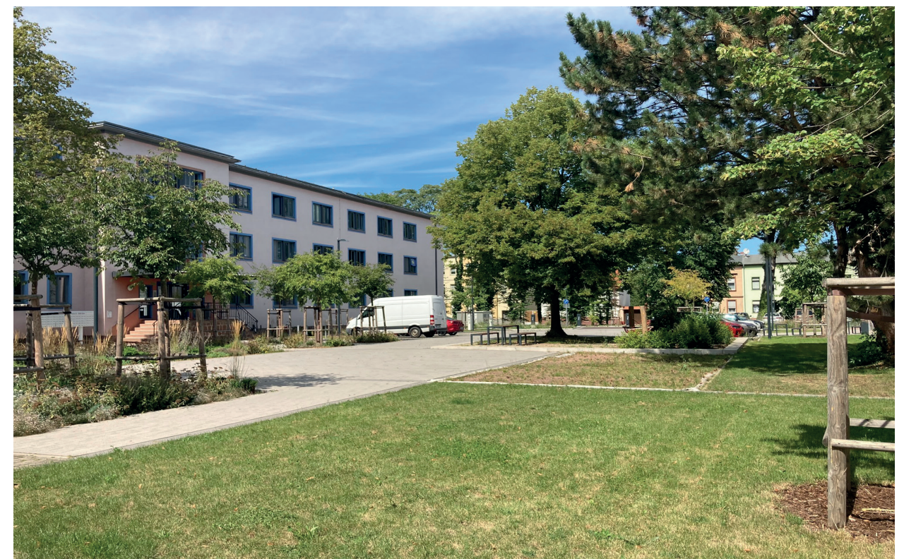
Abb. 05: Baufeld und vorgelagerte Platzgestaltung - Blickrichtung Norden
