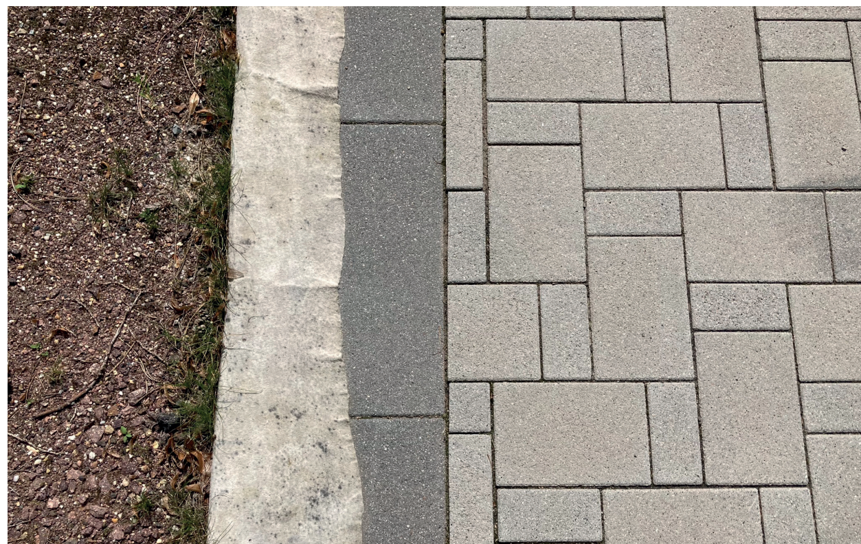
Abb. 07: Bestand - Zu schützendes Plattenband als Einfassung und Betonpflaster FA Rinn
