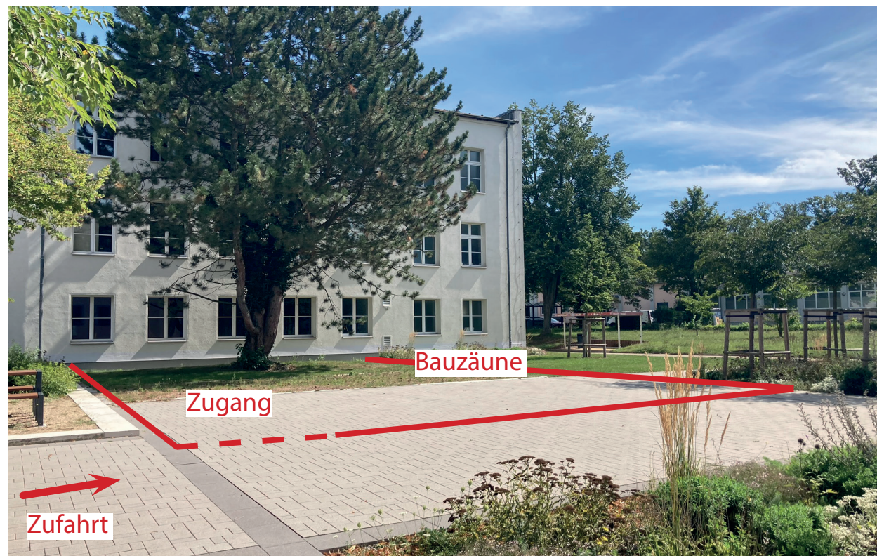
Abb. 03: Baufeld - Sicherung mit Bauzäunen und Zugang zum Baufeld
