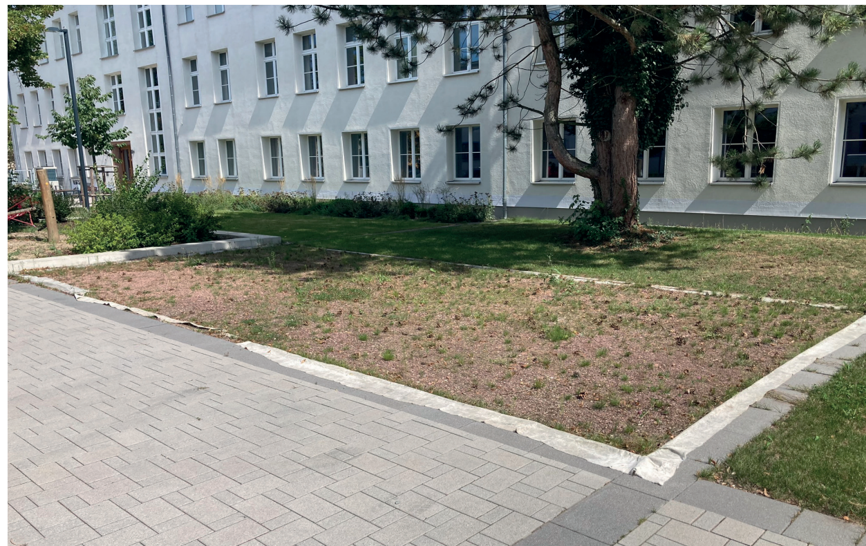
Abb. 05: Bestand - Baufeld mit Schotter verfüllt und allseits eingefasst
