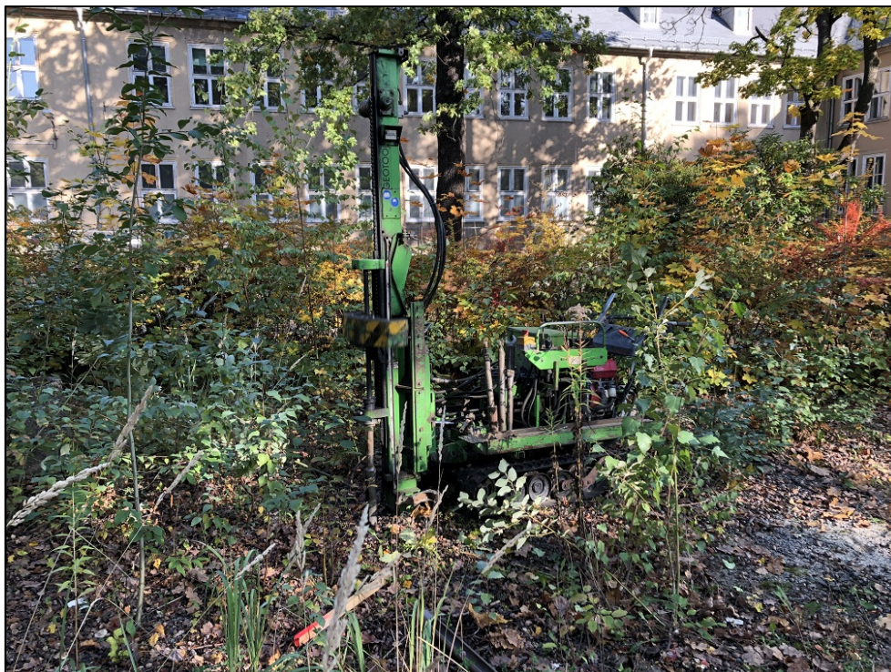
Foto 5: Erkundungsarbeiten am Aufschlusspunkt RKS 7
