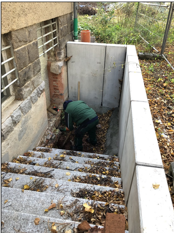
Foto 3: Herstellung des Schurfes unterhalb der Kellertüraussparung in der Baugrubensohle
