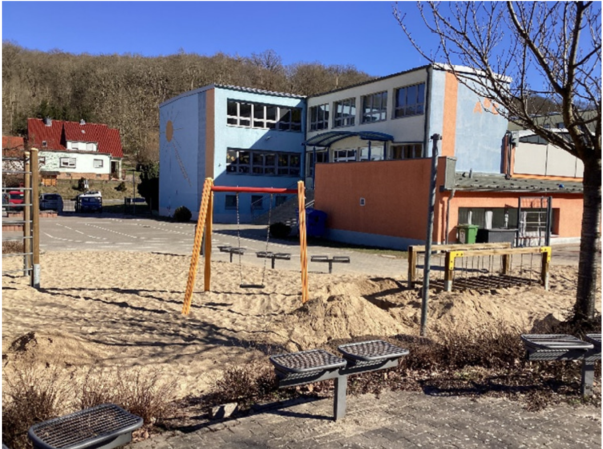
Blick nach Norden auf Schule
