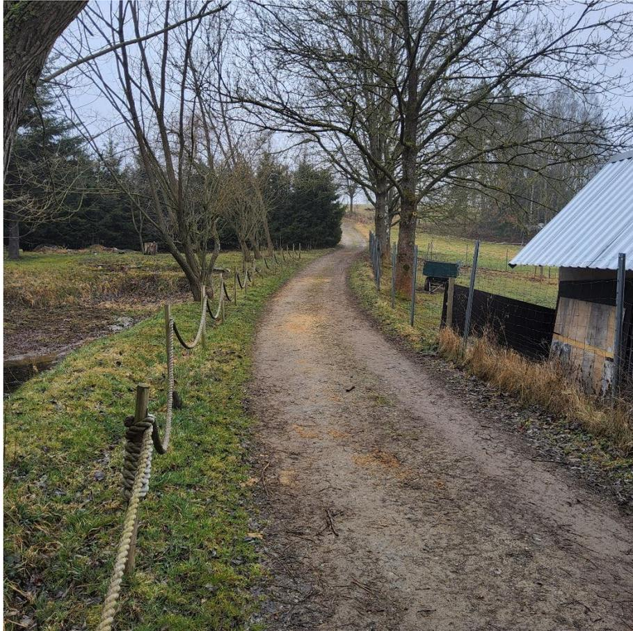
*Bild 4: Fernwanderweg, Zufahrt zum Baufeld; Wegebreite ca. 2,50 m bis max. 3,00 m, beidseitig Einfriedungen und Bewuchs.*
