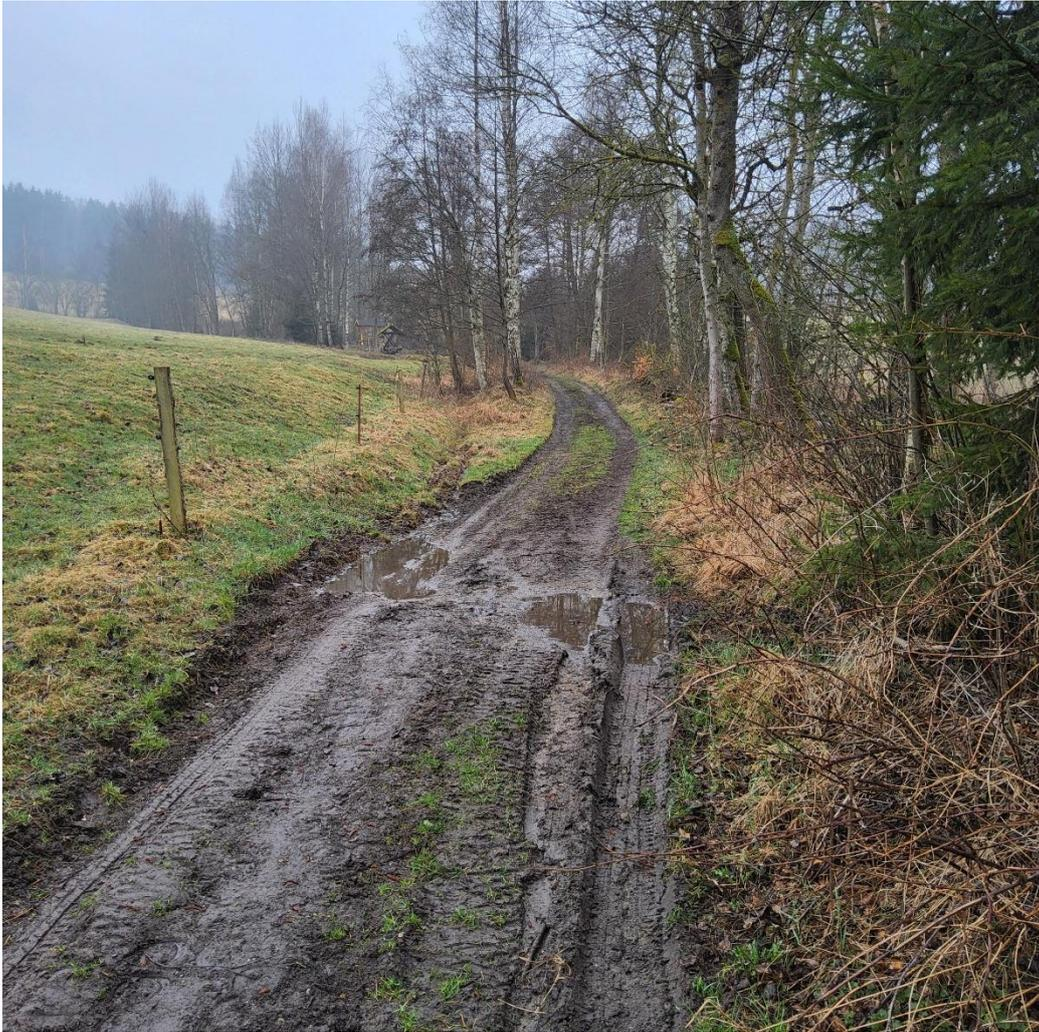
*Bild 11: neu zu errichtende Furt und nachzuprofilierender Graben links im Bild*
