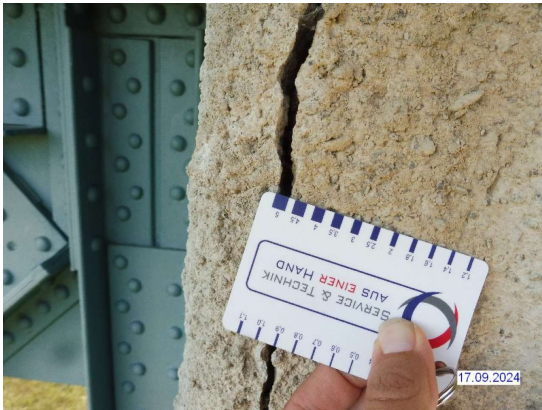
H2024_KAMMERWAND GERISSEN_VORN
