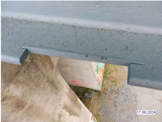
H2024_ÜBERBAU NICHT FACHGERECHT ENTNOMMENE MATERIALPROBE
