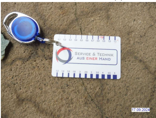
H2024_AUFLAGERBANK NETZRISSE_ALLE
