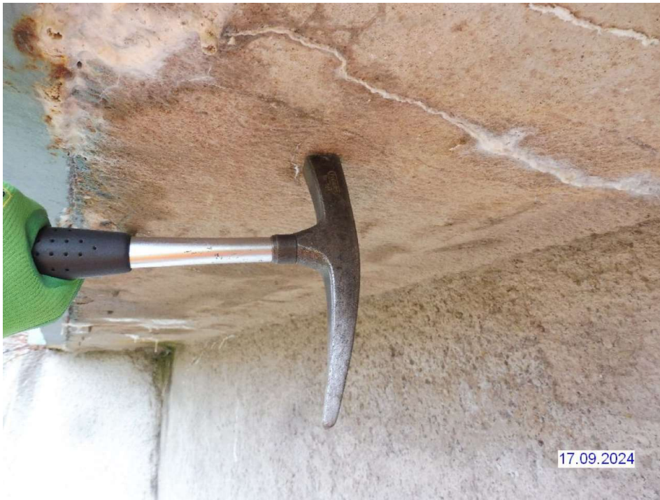
H2024_22_WIDERLAGER VORN INNEN EINSTURZGEFÄHRDETE EINBAUTEN_1
