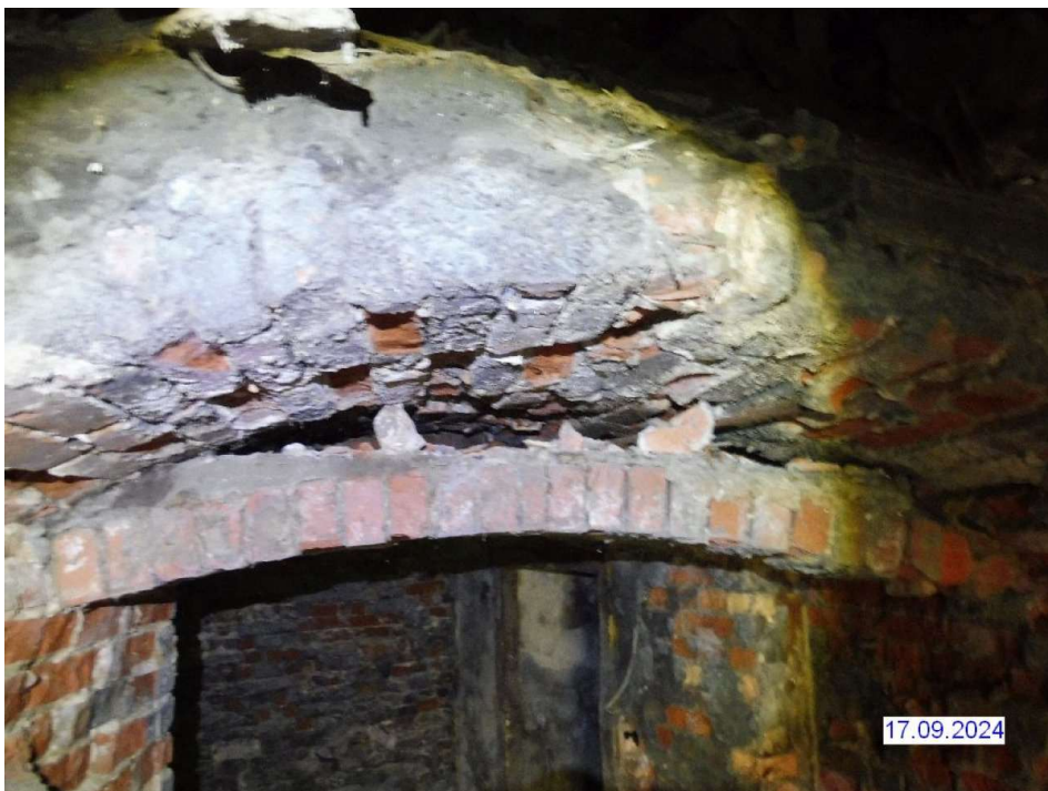
H2024_22_WIDERLAGER VORN INNEN EINSTURZGEFÄHRDETE EINBAUTEN_1
