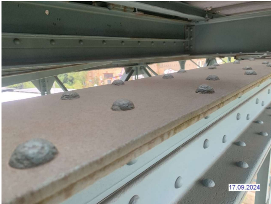
H2024_ÜBERBAU NIETKÖPFE VERNARBT_OBERSEITE OBERGURT
