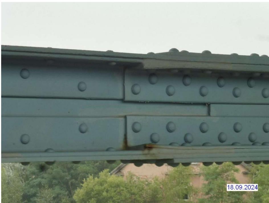
H2024_26_ÜBERBAU MEHRFACH SPALTRÖST_1
