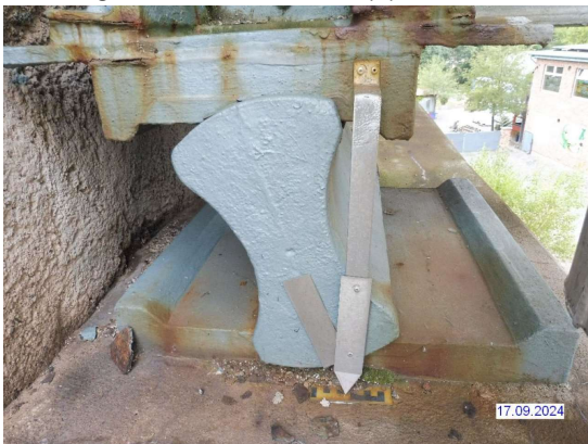
H2024_KIPLAGER UNPLANMÄSSIGE VERSCHIEBUNG_HINTEN
