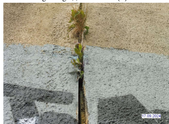
H2024_FLÜGELWAND RAUMFUGEN BEWACHSEN_HINTEN LINKS
