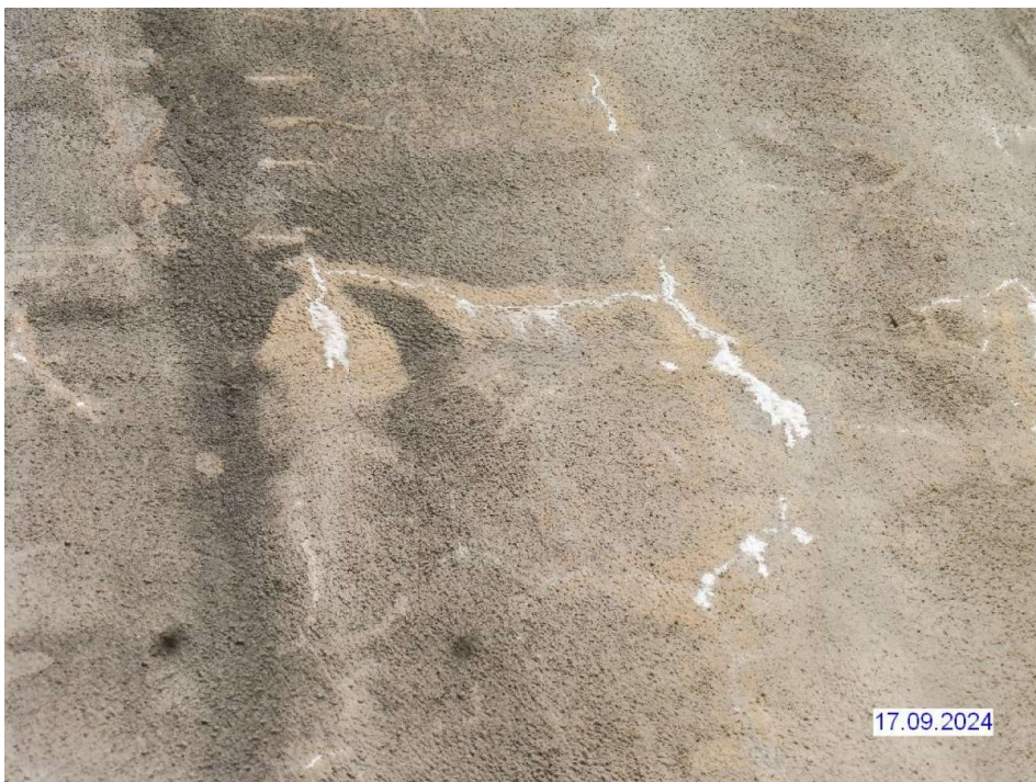
H2024_24_WIDERLAGER VORN UND HINTEN NETZRISSE TEILWEISE MIT AUSSINTERUNGEN_1
