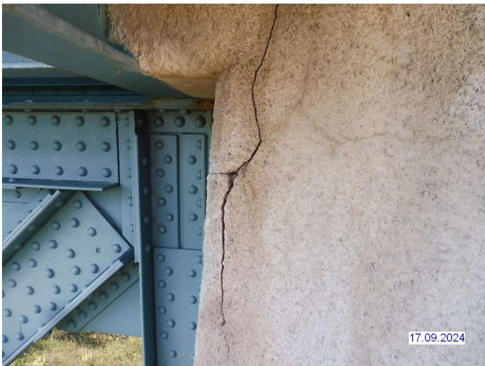
H2024_20_KAMMERWAND VORN GERISSEN_1
