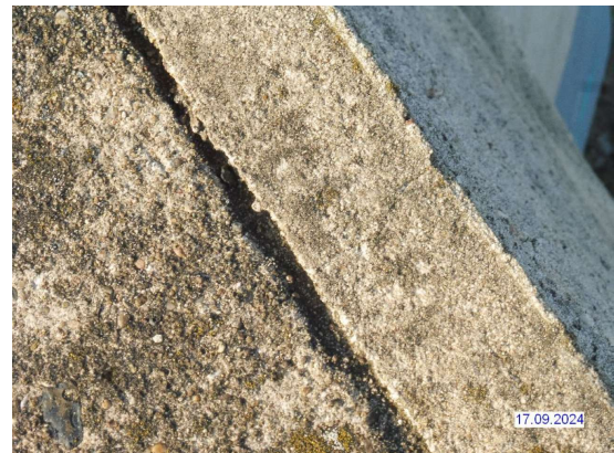
H2024_FLÜGEL ARBEITSFUGE OBERSEITIG OFFEN_HINTEN LINKS
