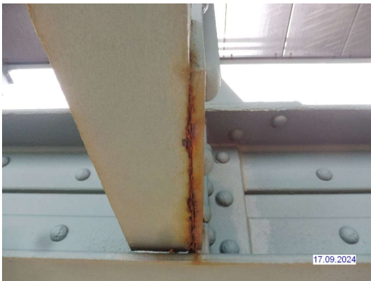
H2024_ÜBERBAU MEHRFACH SPALTROST
