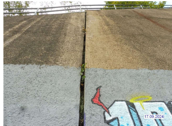
H2024_FLÜGELWAND RAUMFUGENAUSFÜHRUNG OFFEN_HINTEN LINKS
