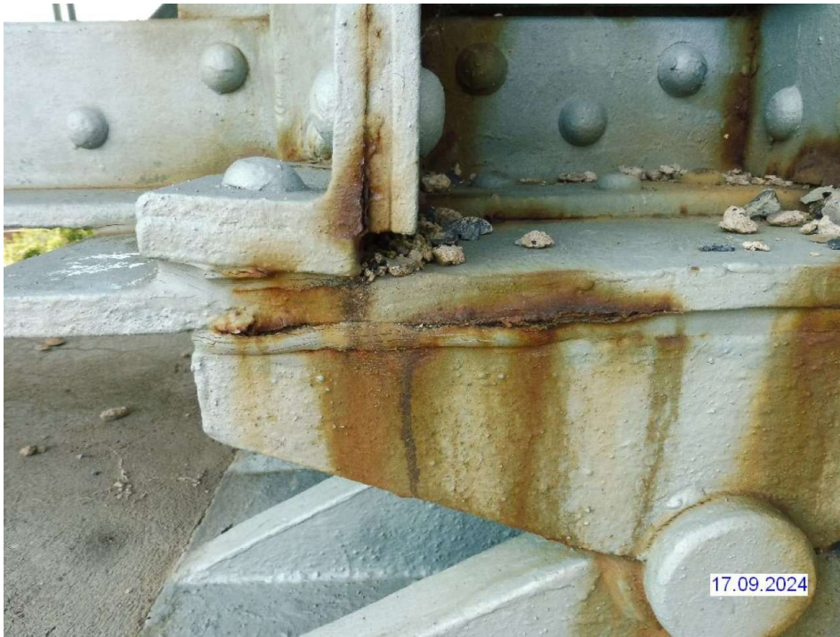
H2024_28_ÜBERBAU MEHRFACH KORROSIONSNARBEN_1
