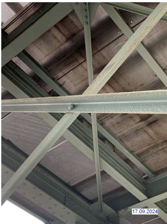
H2024_28_ÜBERBAU MEHRFACH KORROSIONSNARBEN_1
