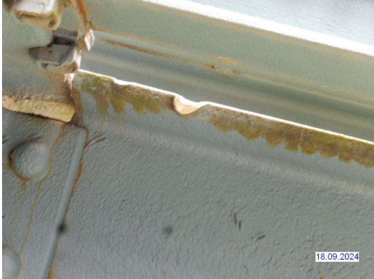
H2024_ÜBERBAU MEHRFACH KERBEN
