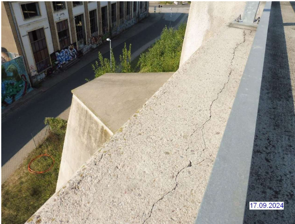
H2024_24_WIDERLAGER VORN UND HINTEN NETZRISSE TEILWEISE MIT AUSSINTERUNGEN_1
