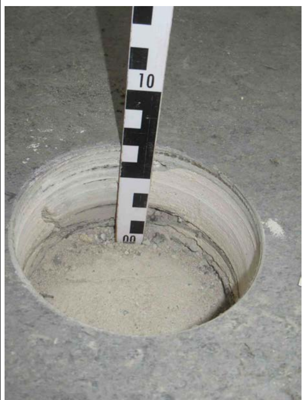
Raum 26 1.OG Probe/Analyse: Trennlage Fußbodenaufbau
