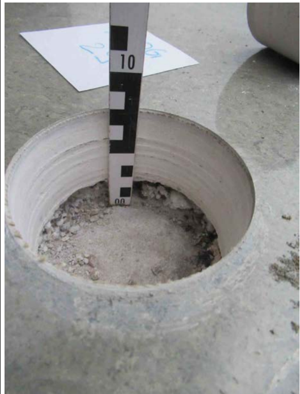
Raum 29 1.OG Probe/Analyse: Trennlage Fußbodenaufbau
