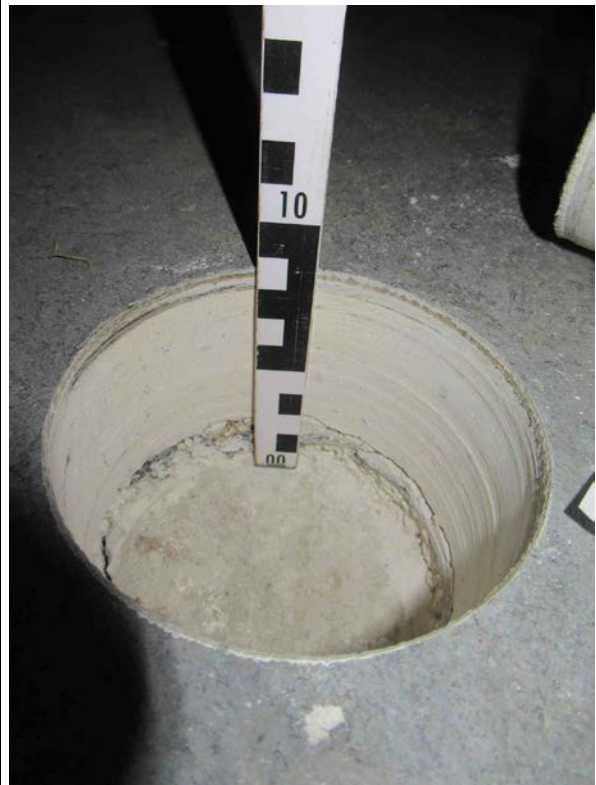
Raum 41 3.OG Probe/Analyse: Trennlage Fußbodenaufbau
