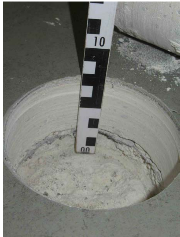
Raum 21 1.OG Probe/Analyse: Trennlage Fußbodenaufbau
