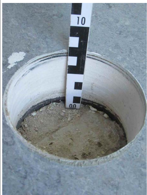
Raum 28 1.OG Probe/Analyse: Trennlage Fußbodenaufbau
