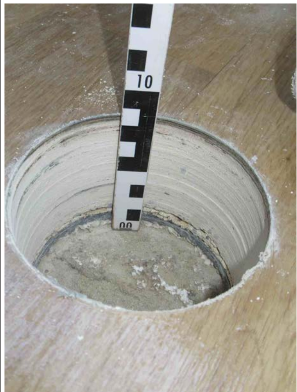
Raum 33 2.OG Probe/Analyse: Trennlage Fußbodenaufbau
