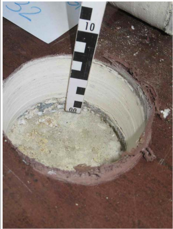
Raum 32 2.OG Probe/Analyse: Trennlage Fußbodenaufbau
