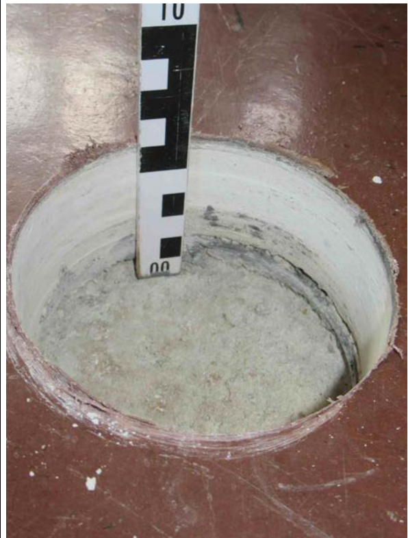
Raum 34 2.OG Probe/Analyse: Trennlage Fußbodenaufbau
