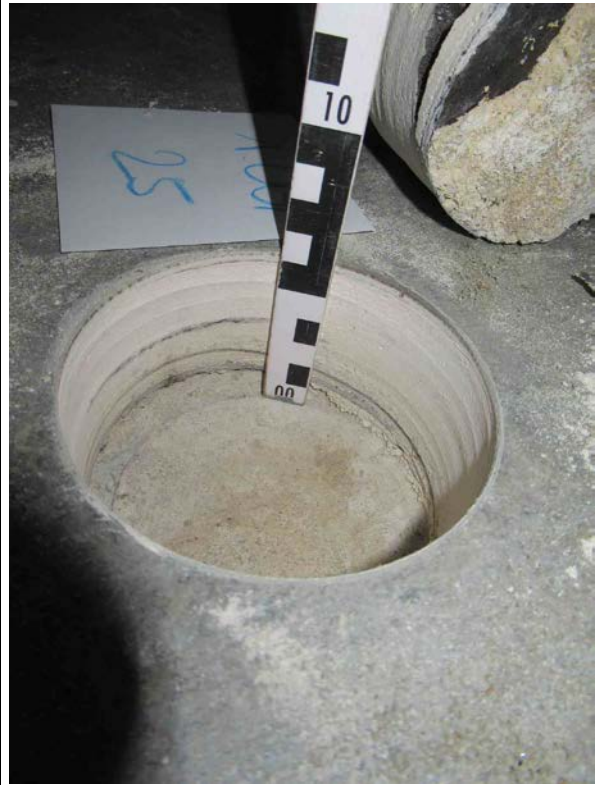
Raum 25 1.OG Probe/Analyse: Trennlage Fußbodenaufbau
