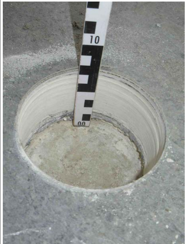
Raum 27 1.OG Probe/Analyse: Trennlage Fußbodenaufbau
