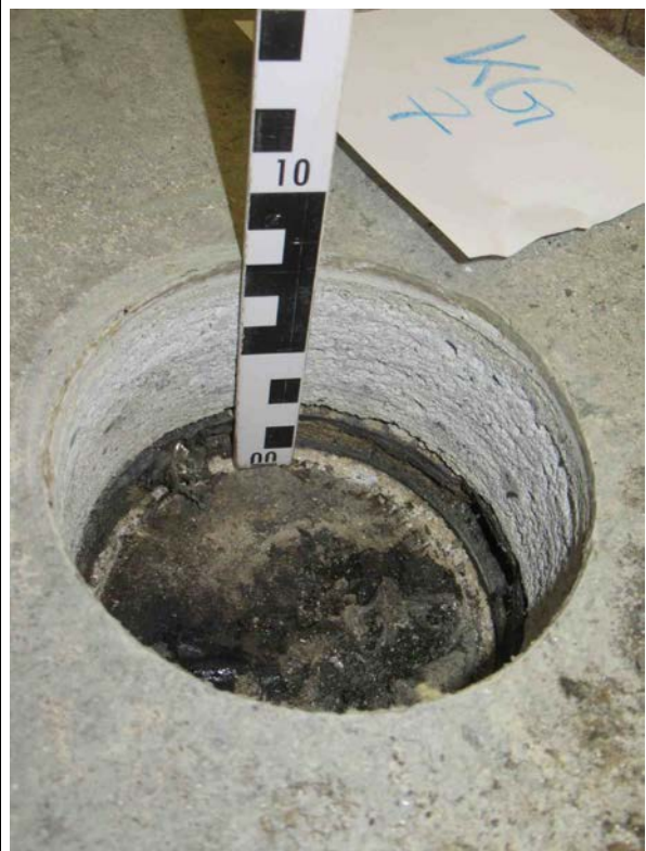
Raum 7 UG Probe/Analyse: Trennlage Fußbodenaufbau und Abdichtung auf Bodenplatte
