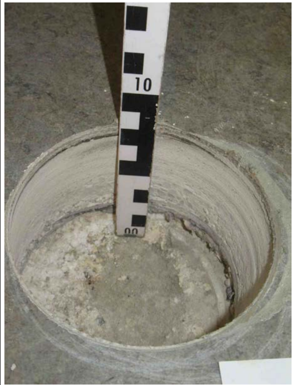
Raum 38 2.OG Probe/Analyse: Trennlage Fußbodenaufbau
