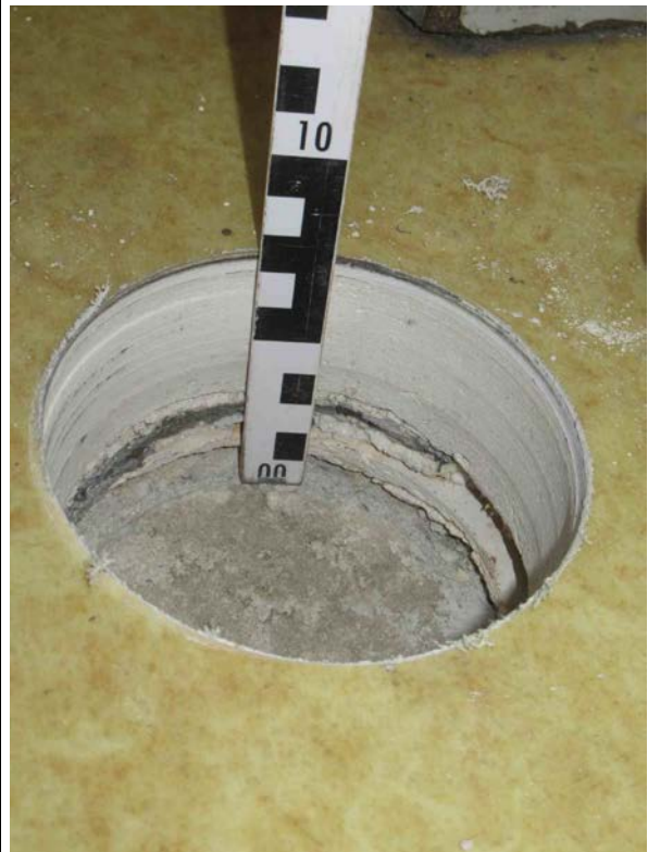
Raum 23 1.OG Probe/Analyse: Trennlage Fußbodenaufbau
