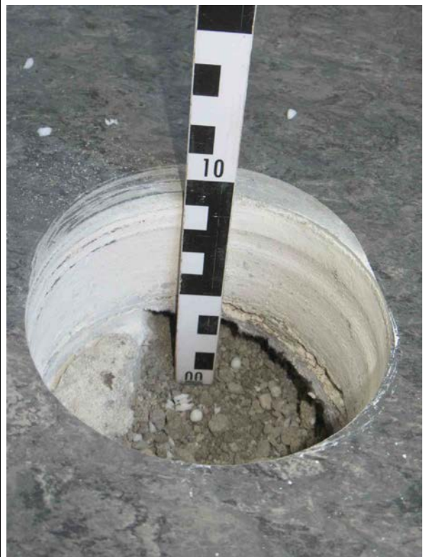
Raum 24 1.OG Probe/Analyse: Trennlage Fußbodenaufbau
