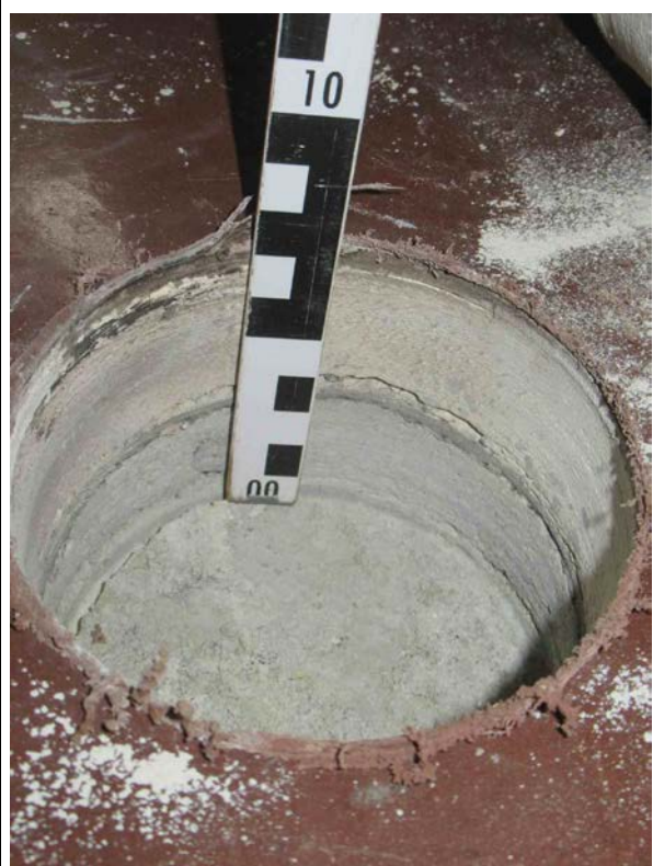
Raum 35 2.OG Probe/Analyse: Trennlage Fußbodenaufbau
