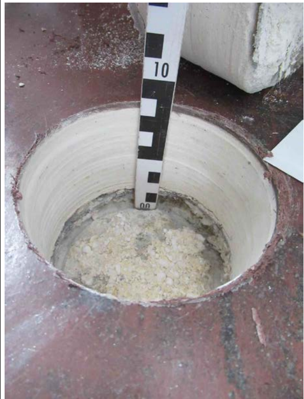
Raum 22 1.OG Probe/Analyse: Trennlage Fußbodenaufbau
