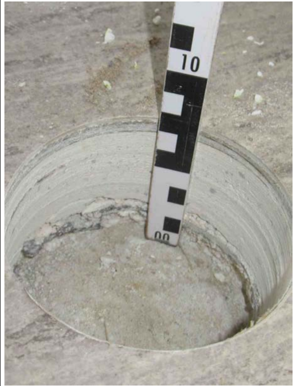
Raum 36 2.OG Probe/Analyse: Trennlage Fußbodenaufbau
