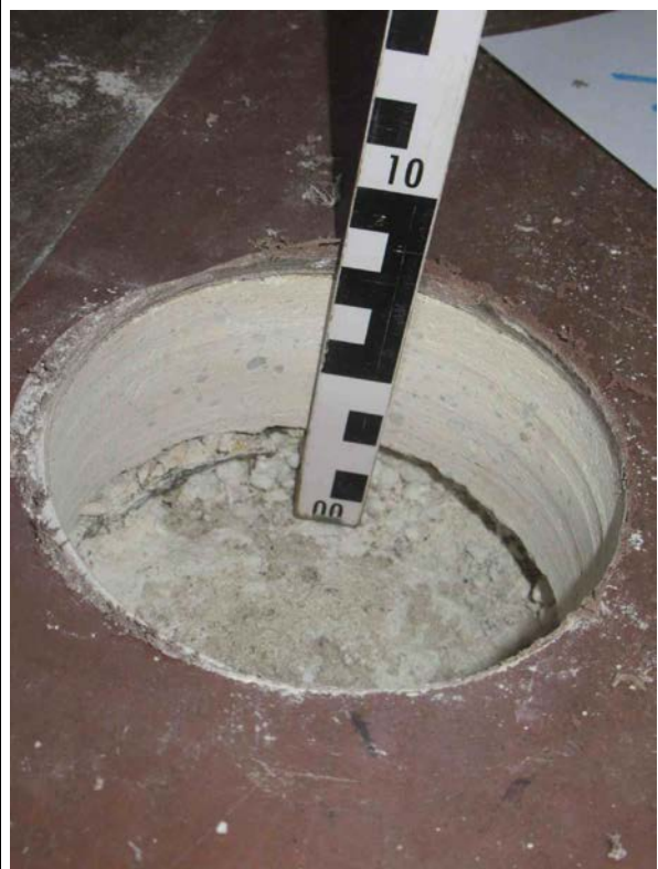
Raum 15 2.OG Probe/Analyse: Trennlage Fußbodenaufbau
