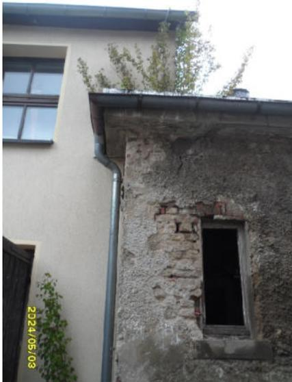
Abb. 25: BV „Gasthof Hartmannsdorf“. Anbindung Dach an Nachbarhaus, 03.05.2024
