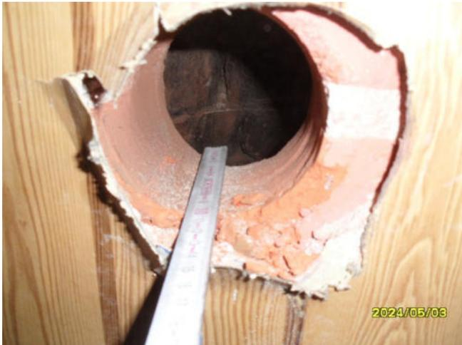
Abb. 49: BV „Gasthof Hartmannsdorf“. Bohrloch Bohrkern 4, 03.05.2024
