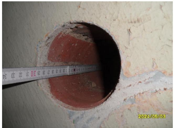
Abb. 58: BV „Gasthof Hartmannsdorf“. Bohrloch Bohrkern 11, 03.05.2024
