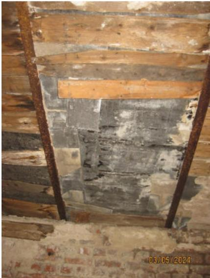
Abb. 43: BV „Gasthof Hartmannsdorf“. Saal-Seitenschiff, Decke mit Asbestzementplatten, EP 11, 03.05.2024
