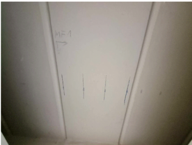
Bewehrungslage am Messpunkt 1
