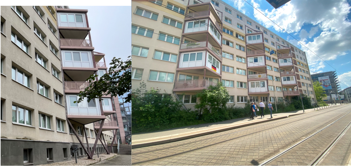
Foto Nord-Ost- i bX 'G' X-West- Fassade [S&P]
