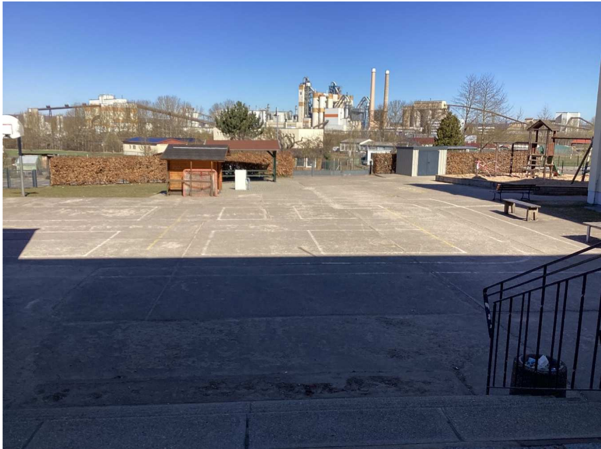
Blick vom Haupteingang auf Zufahrtstor (Richtung Norden)
