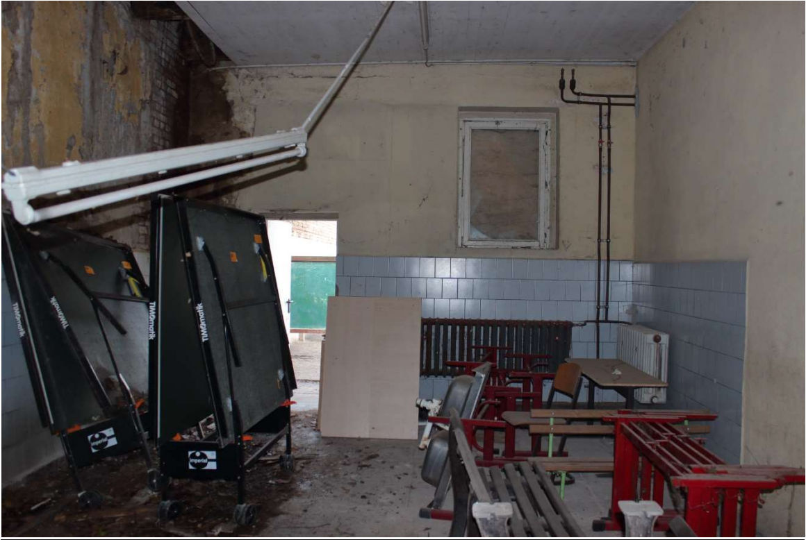
Gebäude – Lagerfläche (ungenutzt)
