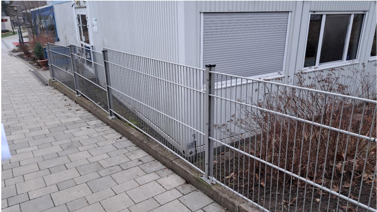
Abbildung 7 Teil des rückzubauenden Zauns im Eingangsbereich Kita (LV-Pos. 2.1.7.); für die Kanten ist ein Überfahrtschutz einzurichten (LV-Pos. 1.3.7., siehe auch folgende Abbildung 8)
