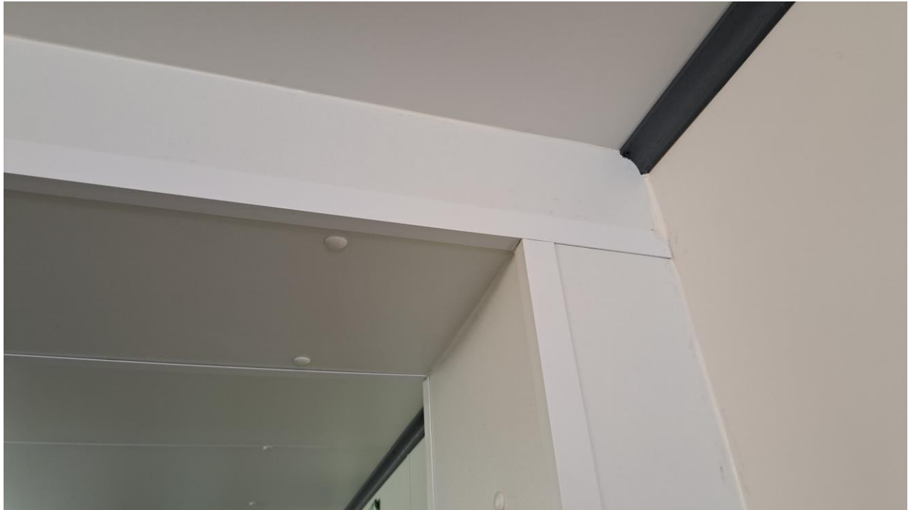
Abbildung 1: typischer Aufbau der Deckenplatten
