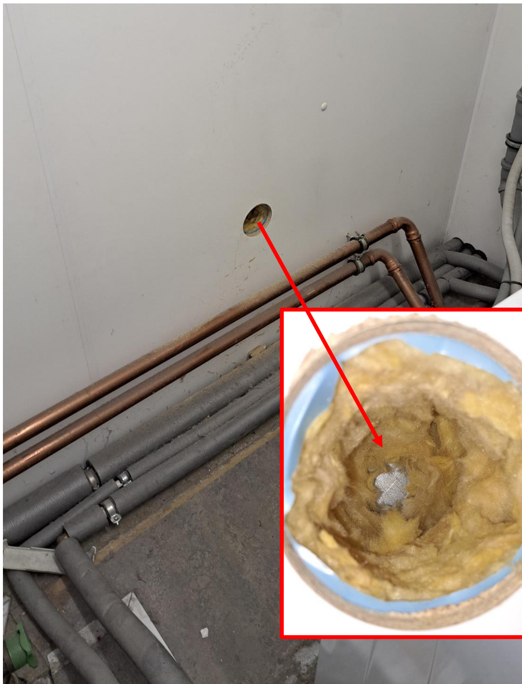
Abbildung 1: Wandöffnung im HA-Raum R16 zur Entnahme der Probe; im kleinen Bild ist die Rückwand aus Blech zu erkennen
