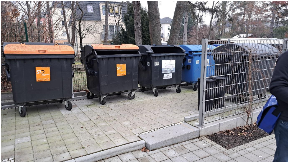
Abbildung 6 Ansicht Müllplatz (LV-Pos. 2.1.8.): die Zaunelemente sind zu entfernen, die Mülltonnen können umplatziert werden, für die Kante im Vordergrund ist ein Überfahrschutz zu errichten (LV-Pos. 1.3.7.)
