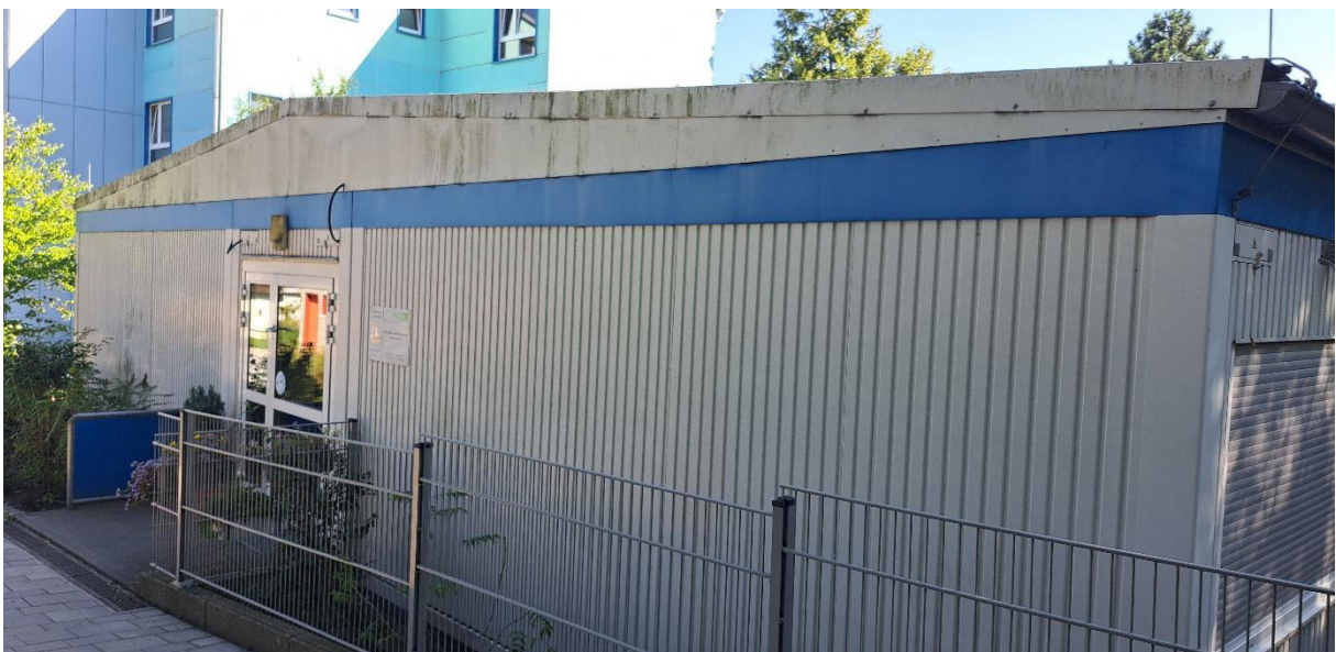
Abbildung 4.1: Ansicht Vordereingang, das Dach ist lediglich als Regenablauf konzipiert, hier sind keine Dämmmaterialien verbaut
