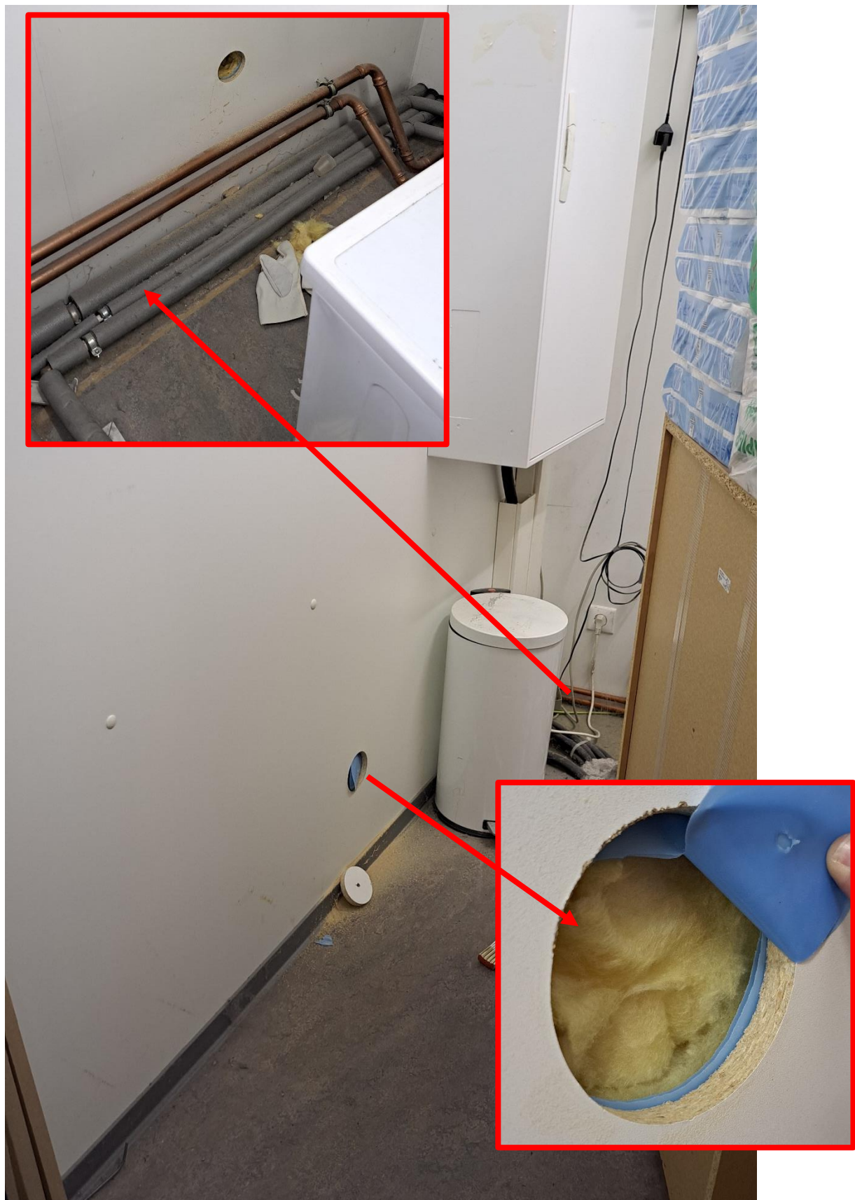
Abbildung 15 Ansicht Technikraum: Innenwandöffnung mit KMF (LV-Pos. 2.4.1.) und Heizungstechnik (LV-Pos. 2.5.2.)
