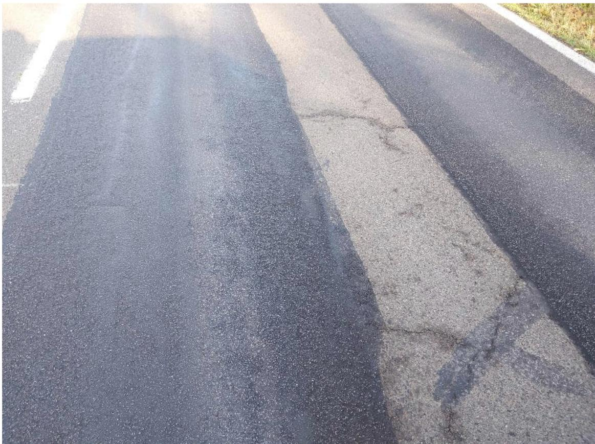
km 1+009: Sanierung der Rollspuren rechts, Querrisse zwischen den Rollspuren
