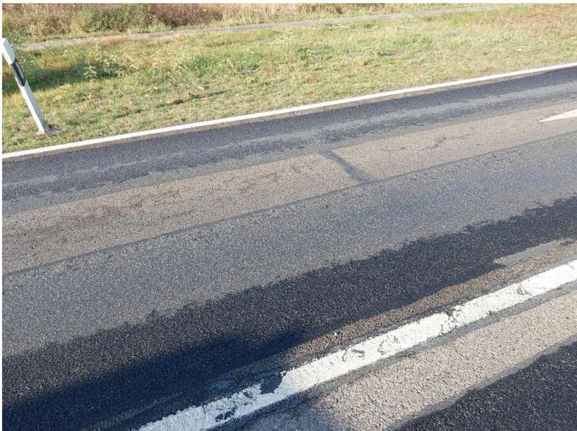
km 0+810: Sanierung der Rollspuren, Netzrisse zwischen den Rollspuren links
