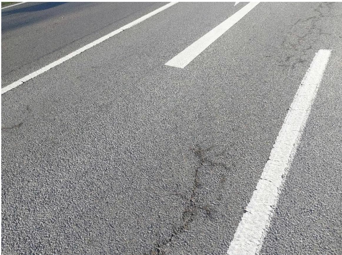
km 0+950: Längs- und Netzrisse in Rollspuren der Linksabbiegespur zur K 9202
