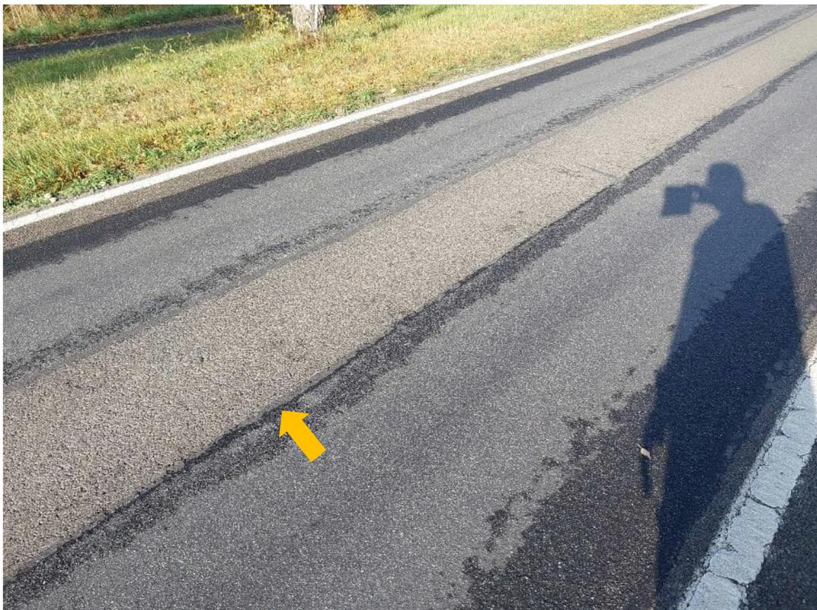
km 1+009: Sanierung der Rollspuren links, schadhafte Arbeitsnaht
