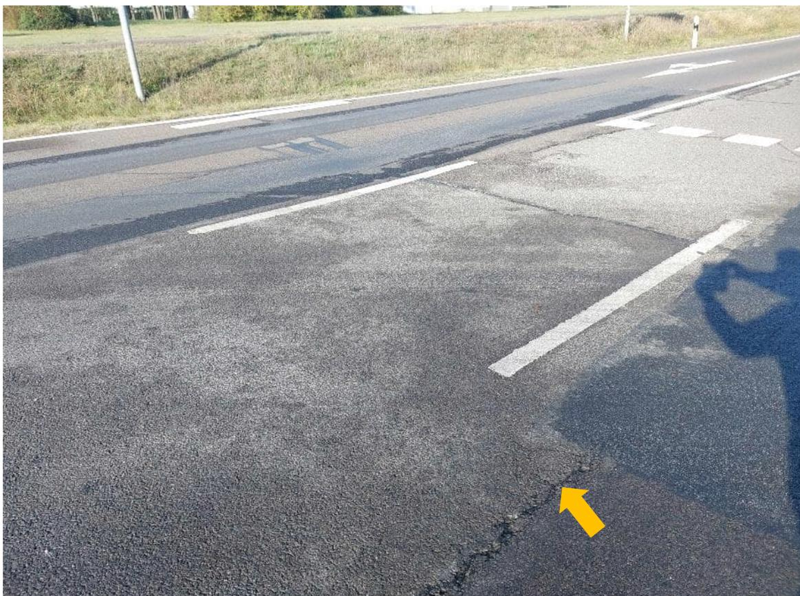
km 1+107: Kornausbrüche entlang schadhafter Arbeitsnaht rechts
