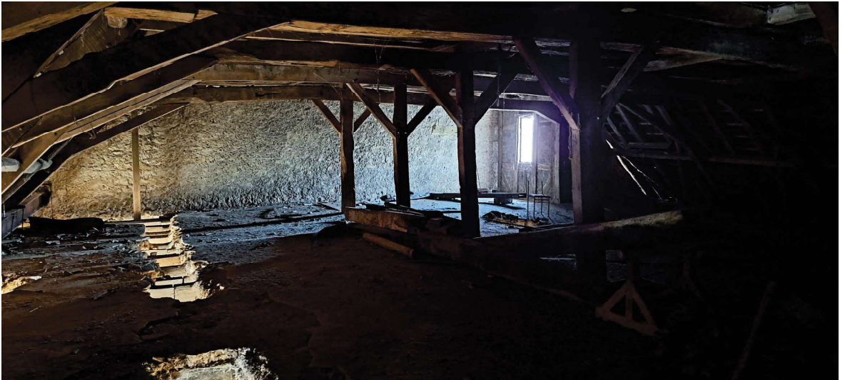
Ablastung Dachstuhl Mittelachse
