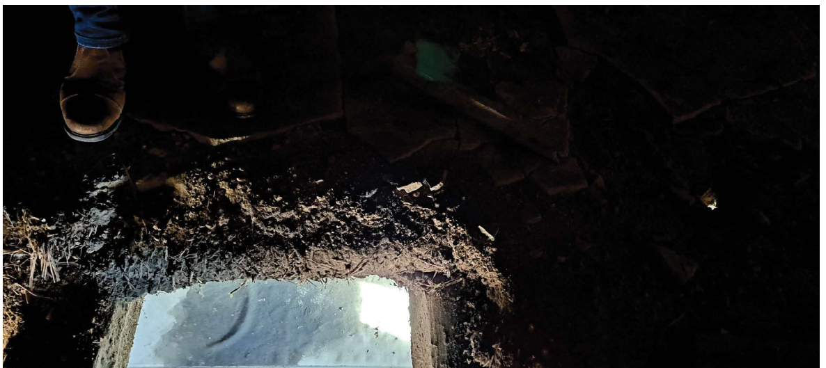
Decke über 2. OG
