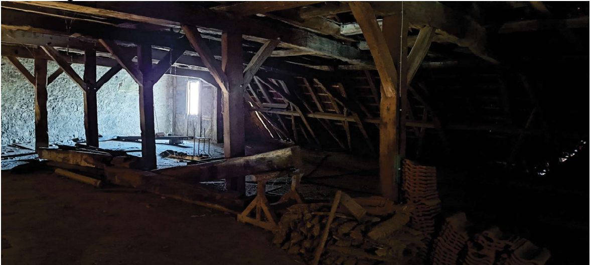
Ablastung Dachstuhl Ost
