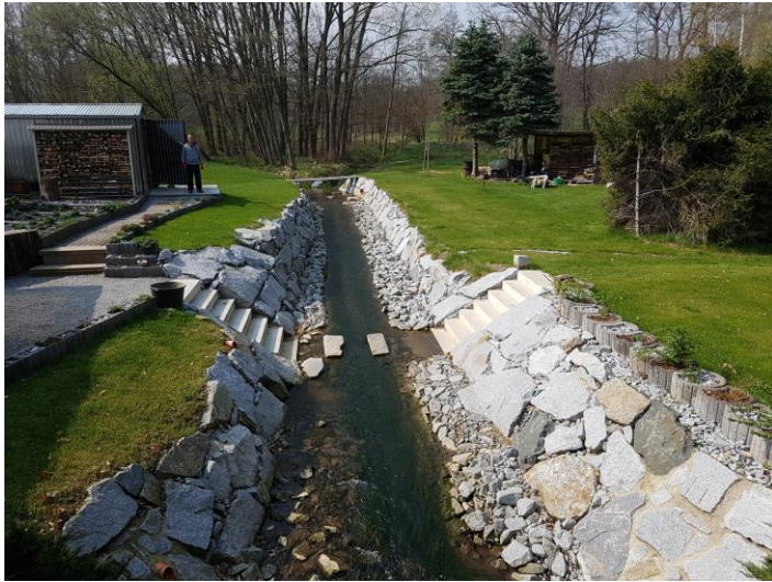
Abb. 3: Neu gestaltete Uferbefestigung Silberwasser oberstromseitig
