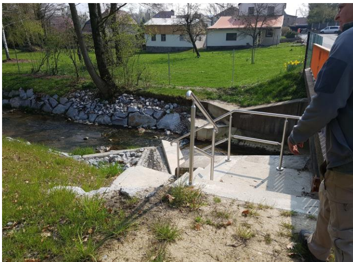
Abb. 2: Löschwasserentnahmestelle mit Zuwegung
