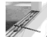
Bild 4/52: Beim Aufmauern wird der Edelstahl-Flachanker im Mörtelbet eingestellt.
