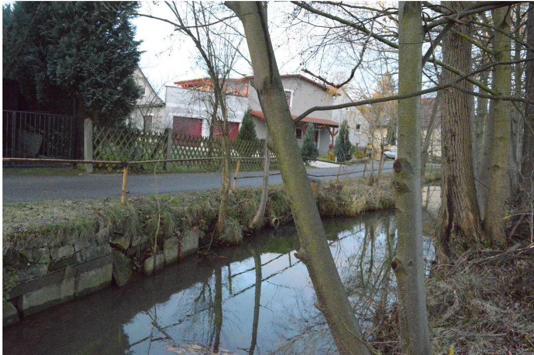
Abbildung 3 30.11.2017, ca. Gewässerstation 16+435 (links im Bild) bis ca. 16+415, Ende der Stützmauer bei ca. 16+438
