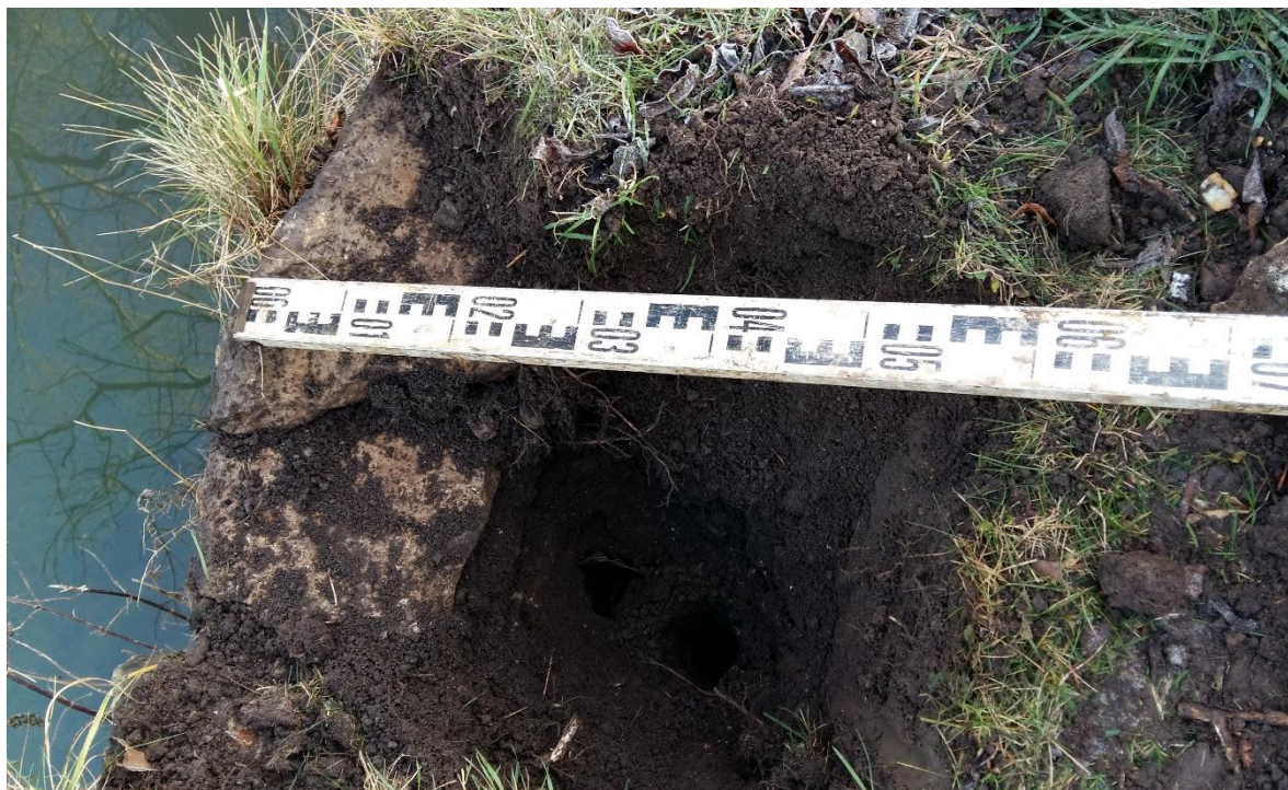
Abbildung 2 30.11.2017, Blick in den SCH 1/17, Mauerrückseite ist senkrecht ausgebildet, Mauerdicke beträgt ca. 0,30 m
