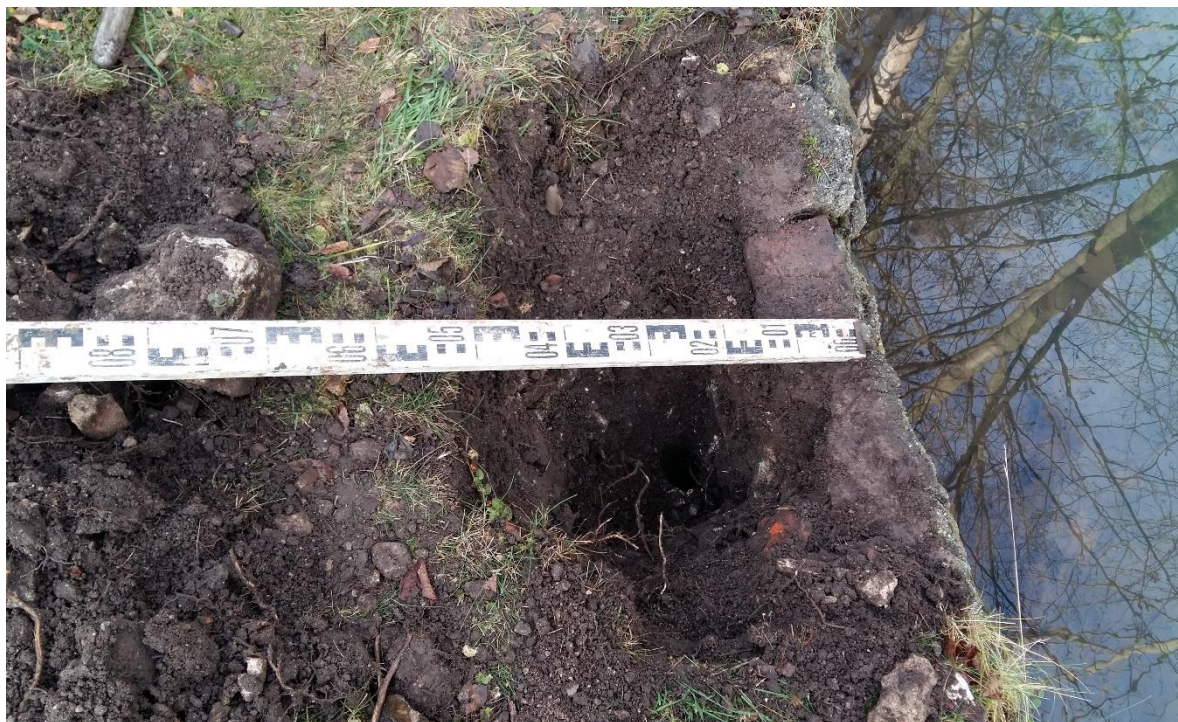
Abbildung 4 30.11.2017, Blick in den SCH 2/17, Mauerrückseite ist senkrecht ausgebildet, Mauerdicke beträgt ca. 0,20 m
