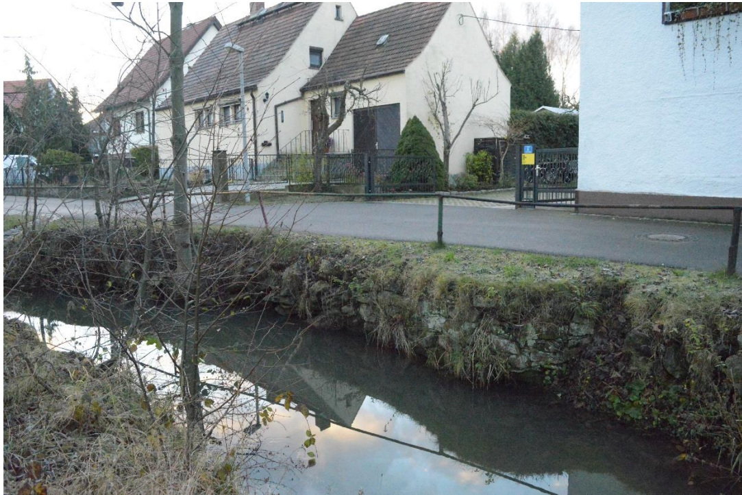
Abbildung 1 30.11.2017, ca. Gewässerstation 16+453 (links im Bild) bis ca. 16+440, Beginn der Stützmauer bei ca. 16+453
