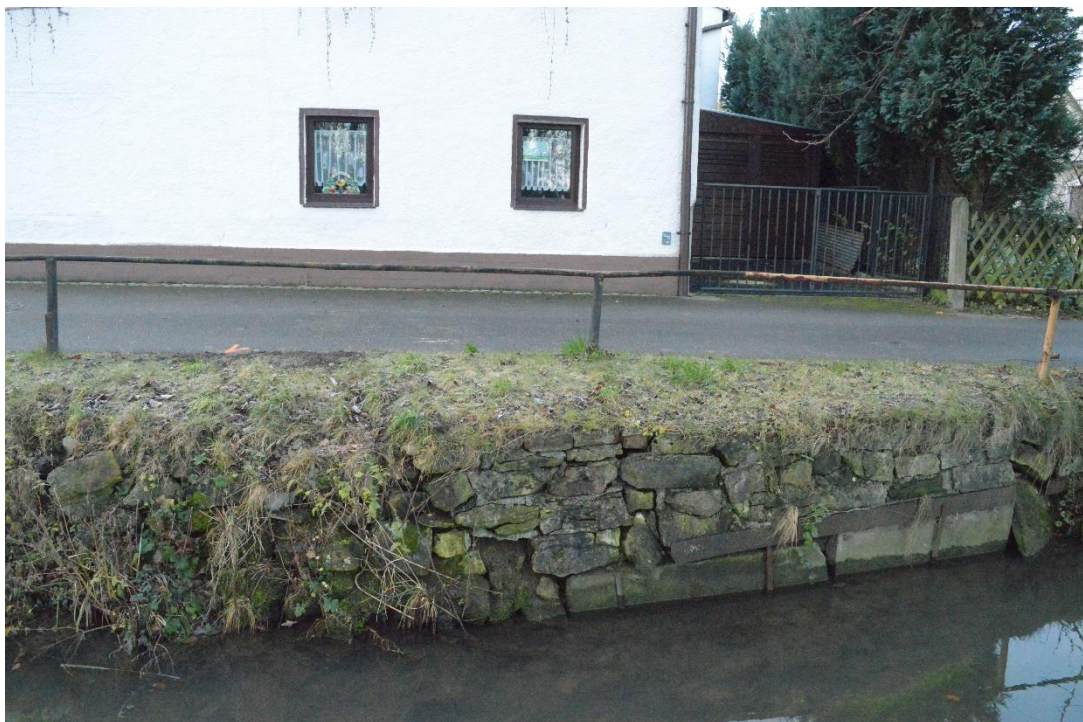
Abbildung 2 30.11.2017, ca. Gewässerstation 16+440 (links im Bild) bis ca. 16+435
