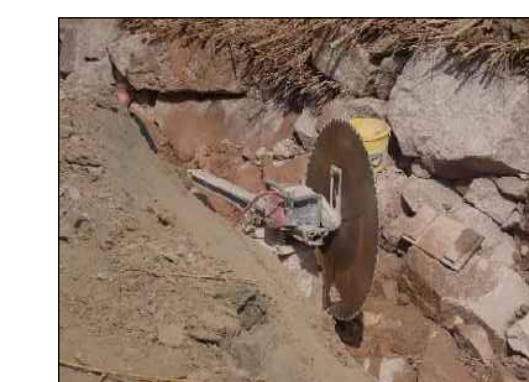
Abbildung 6 Das Nacharbeiten der Begrenzungssteine an den Riegelöffnungen dient der geometrischen und hydraulischen Optimierung der Riegelöffnungen - Anströmen und Herstellen ausreichend großer Riegelöffnungen
