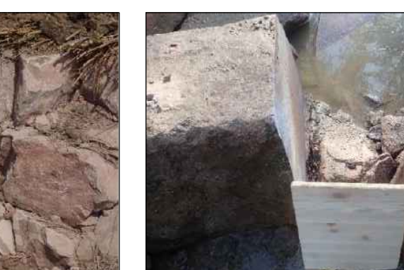
Abbildung 7 Riegelöffnungen in ausreichender Größe nach Korrektur (28-32 cm)
