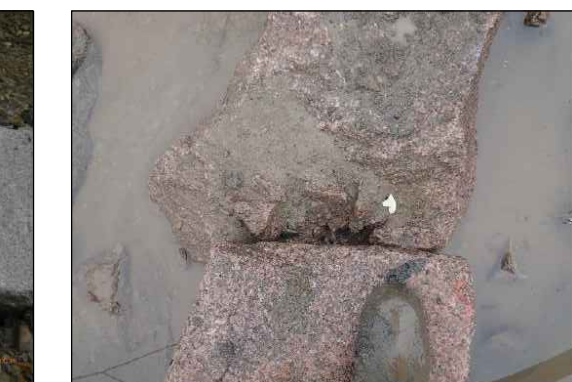
Abbildung 13 Querriegel (Draufsicht), Steine dicht gefügt
