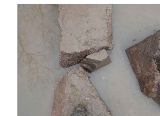
Abbildung 14 Querriegel, Steine schließen nicht dicht genug ab
