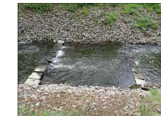
Abbildung 5 Riegelsteine angeschrägt, um eine seitliche Anströmung der Riegelöffnung und eine Ablösung des Strahls zu vermeiden
