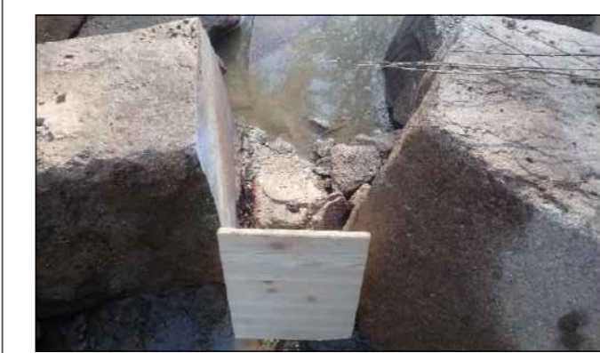
Abbildung 7 Riegelöffnungen in ausreichender Größe nach Korrektur (28-32 cm)
