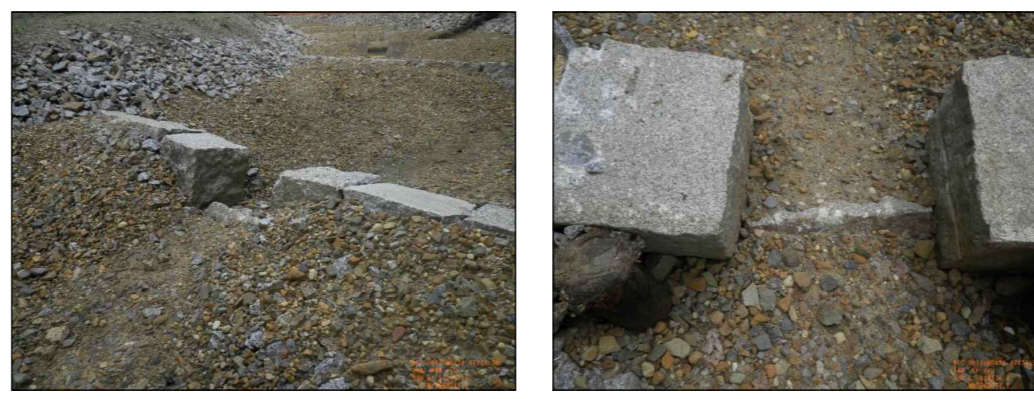
Abbildung 2: Schwellensteine mit Kante nach oben gesetzt und angeschüttet = die unterwasserseitige Anschüttung sollte mit einer größeren Korngrößenfraktion als auf dem rechten Bild dargestellt erfolgen, da es ansonsten zu Ausspülungen kommen kann
