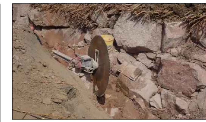
Abbildung 6 Das Nacharbeiten der Begrenzungssteine an den Riegelöffnungen dient der geometrischen und hydraulischen Optimierung der Riegelöffnungen - Anschraffen und Herstellen ausreichend großer Riegelöffnungen
