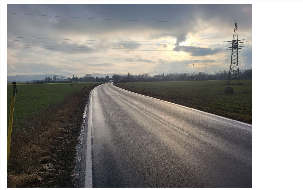
Bild 3 L2662 – Leitungsquerung Hochspannung
