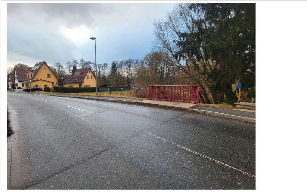
Bild 11 L2662 Bauwerk Lindenbachgraben
