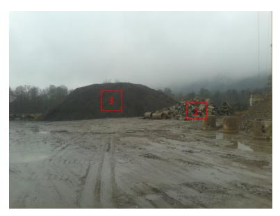
Umsetzung komplett notwendig, Schüttkegel mit ca. 40% Luftanteilen, Ansatz von 60% Umsetzungsmasse
