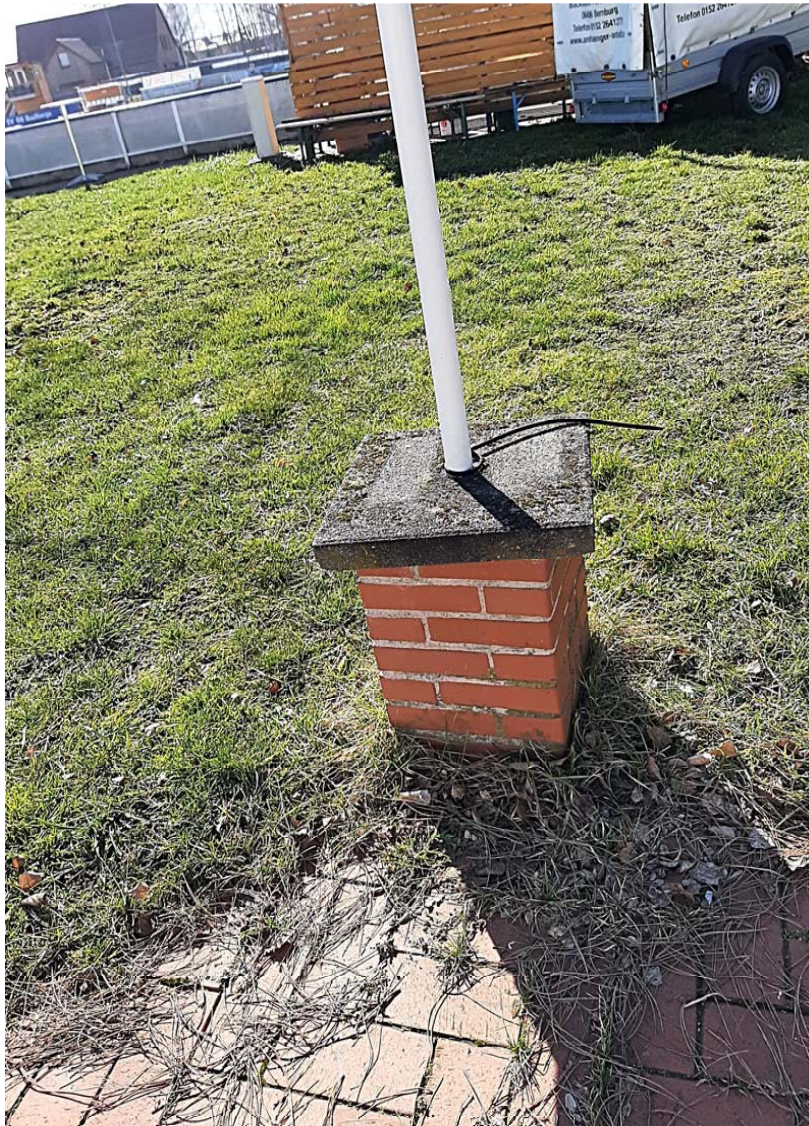
Abbruch Außenleuchte mit Sockelmauerwerk, Platte und Gründung
