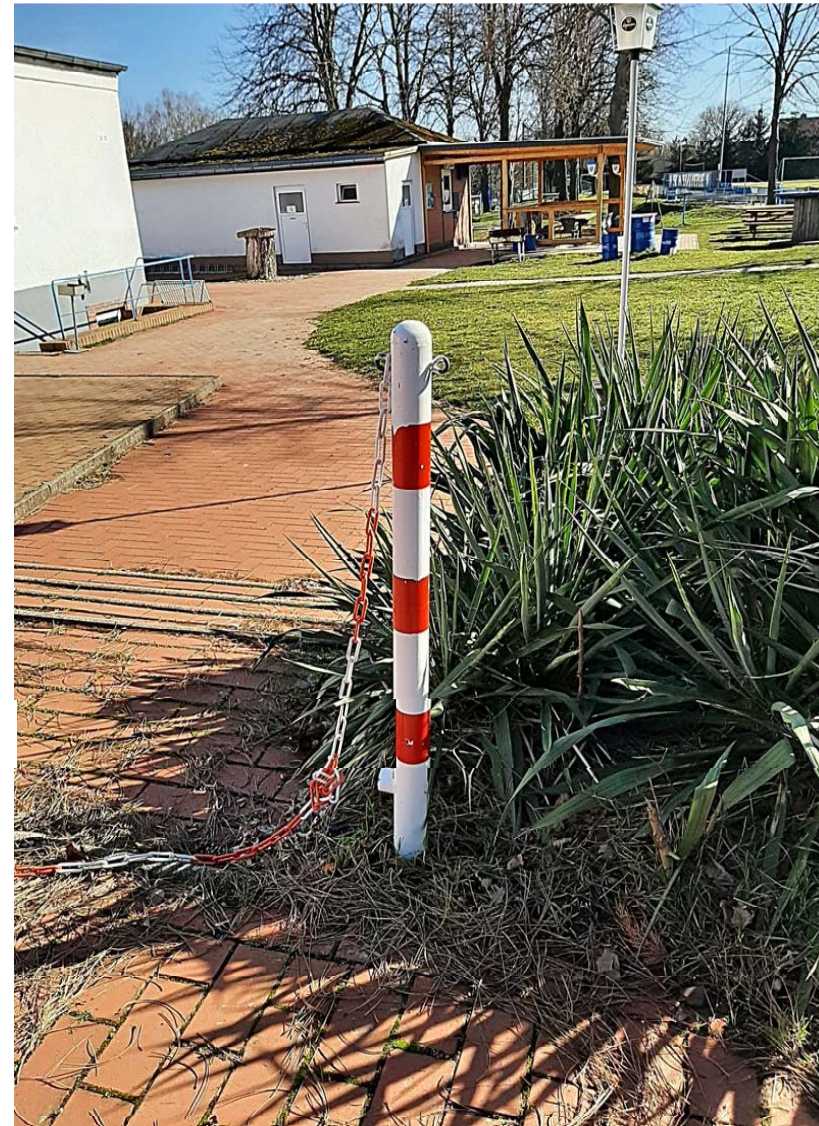
Abbruch Pfosten mit Gründung und Kette
