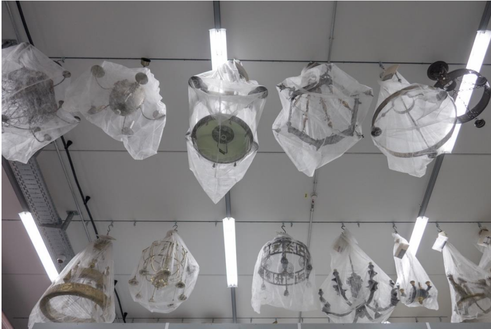
Deckenhängung von Halfenschiene
