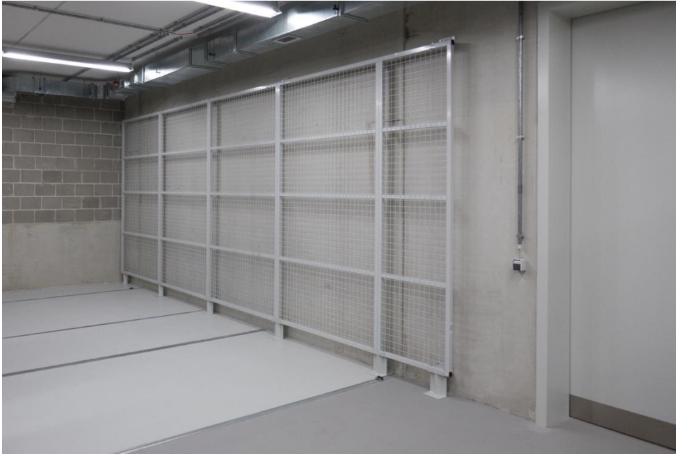
Gitter fix an Wand (Lastabtragung über Boden)
