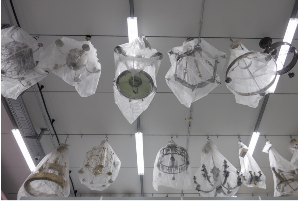
Deckenhängung von Halfenschiene
