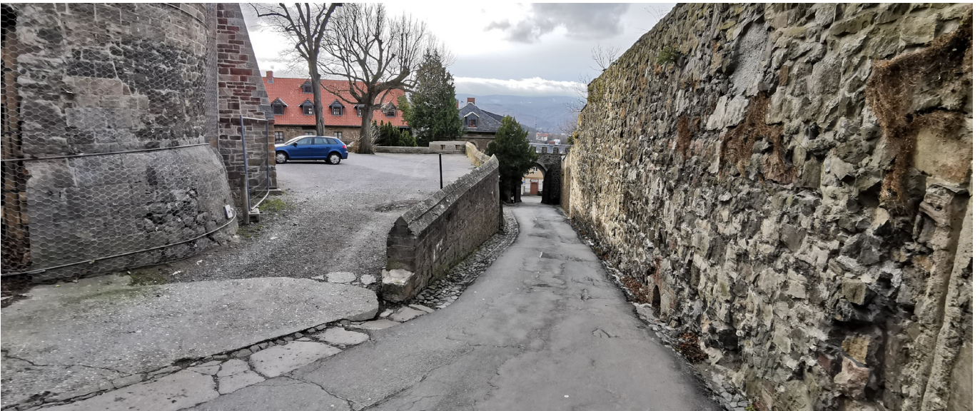
BT 1 - Schlosstraße / unterer Teil mit Blick auf Zufahrt Bäckerhof
