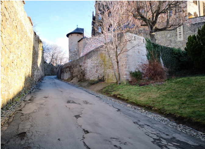
Bäckerhof, Blick entlang der Schlosstraße
