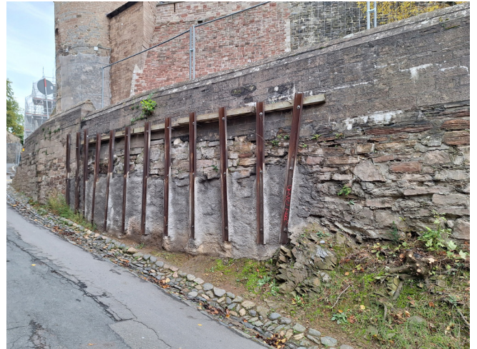
Bäckerhof, Blick aus die Stützmauer mit der Sicherungskonstruktion
