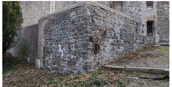
Bäckerhof, auf die vordere Ecke, Zustand 2020
