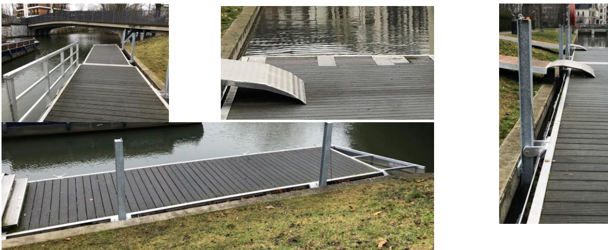
Abb. 2-8: Fotos der Bestandsanlage an der Außenmole am temporären Liegeplatz (Fotos FWT vom 19.01.2022)
