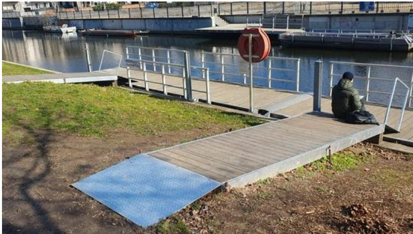
Abb. 5-2: Aktueller Zustand (Benutzerfreundliche Übergangsbleche) (Foto AG)
