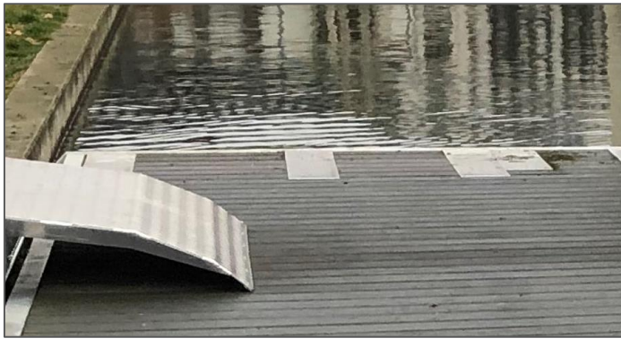
Abb. 5-1: Gleitschienen der Bestandsanlage an der Außenmole (Foto FWT vom 19.01.2022)
