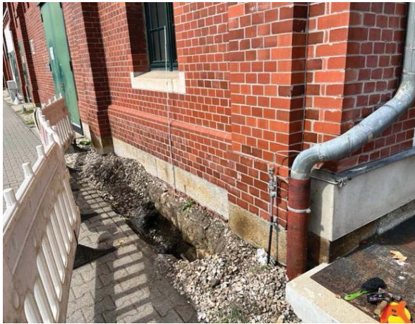
Bild 7 – Schachtung SO-Ecke aussen
