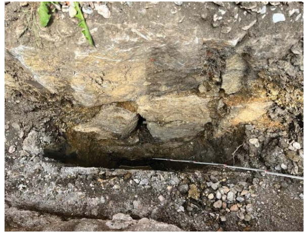
Bild 8 – Schachtung SO-Ecke aussen
