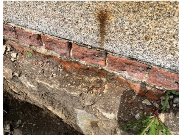
Bild 9 - Gefüge Gründungsmauerwerk - Übergang
