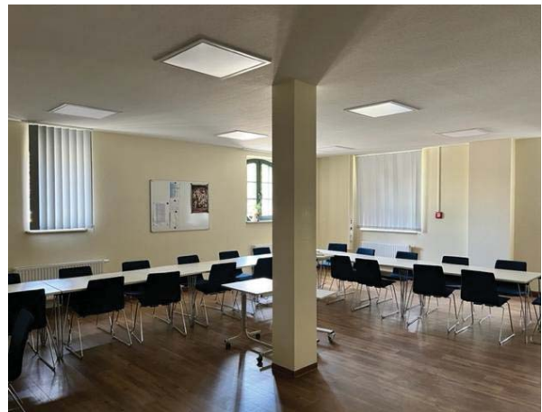
Bild 11 – Stütze Beratungsraum Bestand Nordseite
