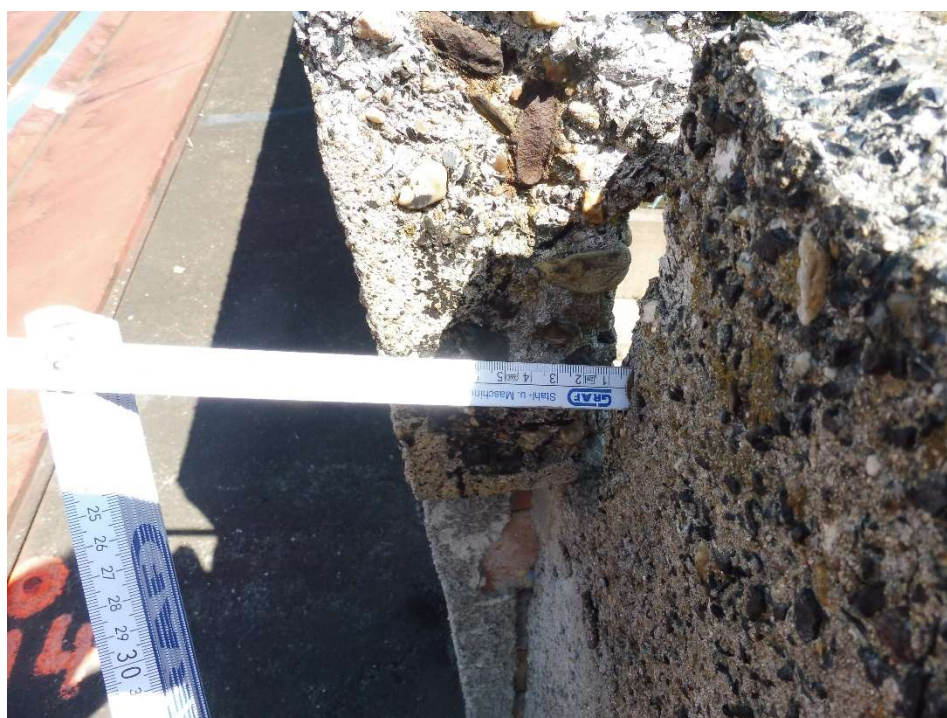
Bild 8: verkippte Stirnwände (Stand: 05.2024)
