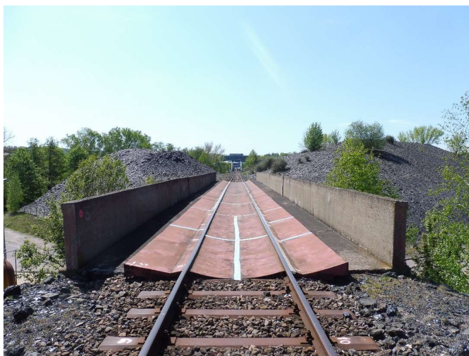
Bild 4: Oberbauansicht, Blick nach hinten (Stand: 05.2024)
