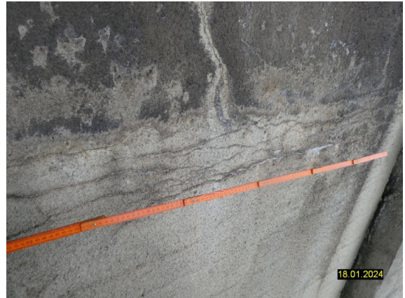
H2023_STIRNWAND LÄNGSRISSE
