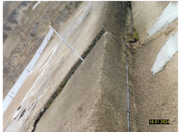
H2023_FLÜGEL SCHRÄGRISS MIT FLANKENVERSCHIEBUNG
