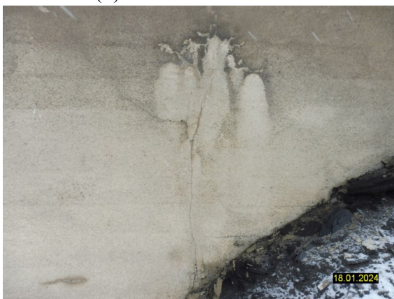
H2023_FLÜGEL SCHRÄGRISS
