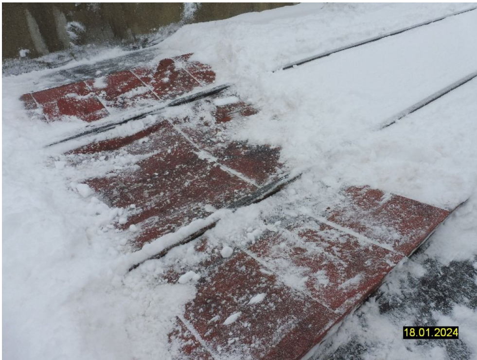
H2023_12_VERBLECHUNG GLEISSCHOTTER
