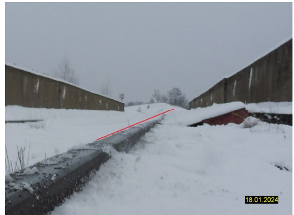
H2023_GLEISROST SETZUNG
