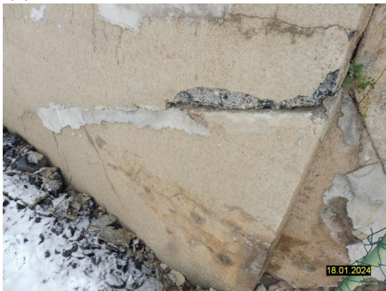
H2023_FLÜGEL KÄMPFERBEREICH SCHRÄGRISS
