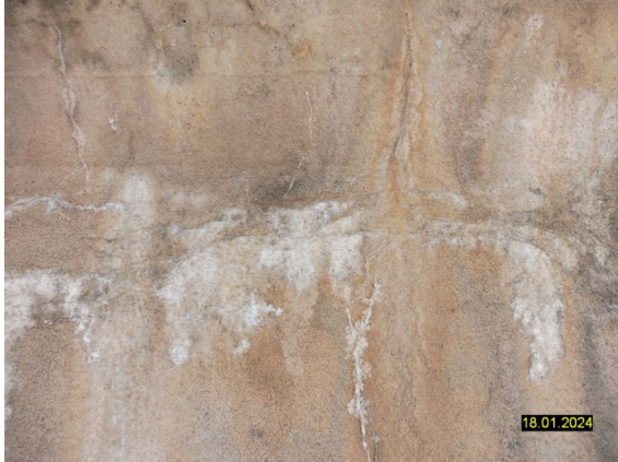
H2023_KÄMPFER QUERRISSE MIT AUSSINTERUNGEN
