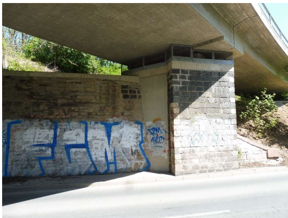
Bild 6: Ansicht vorderer, erster Pfeiler und Überbau vorn (Stand: 05.2024)
