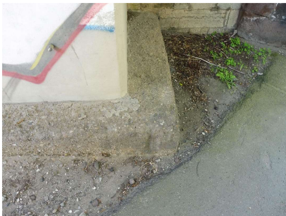
Bild 11: hintere zweite Pfeiler, Fundamentoberseite freiliegend (Stand: 05.2024)
