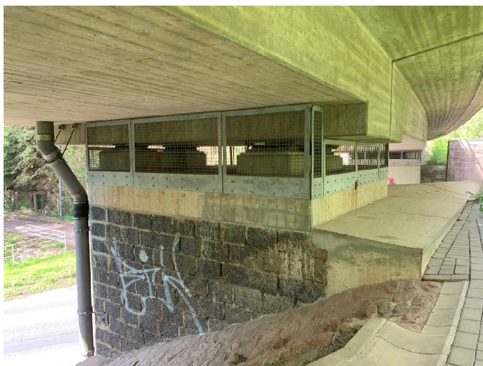
Bild 8: Ansicht Pfeilerkopf vorderer, erster Pfeiler (Stand: 05.2024)
