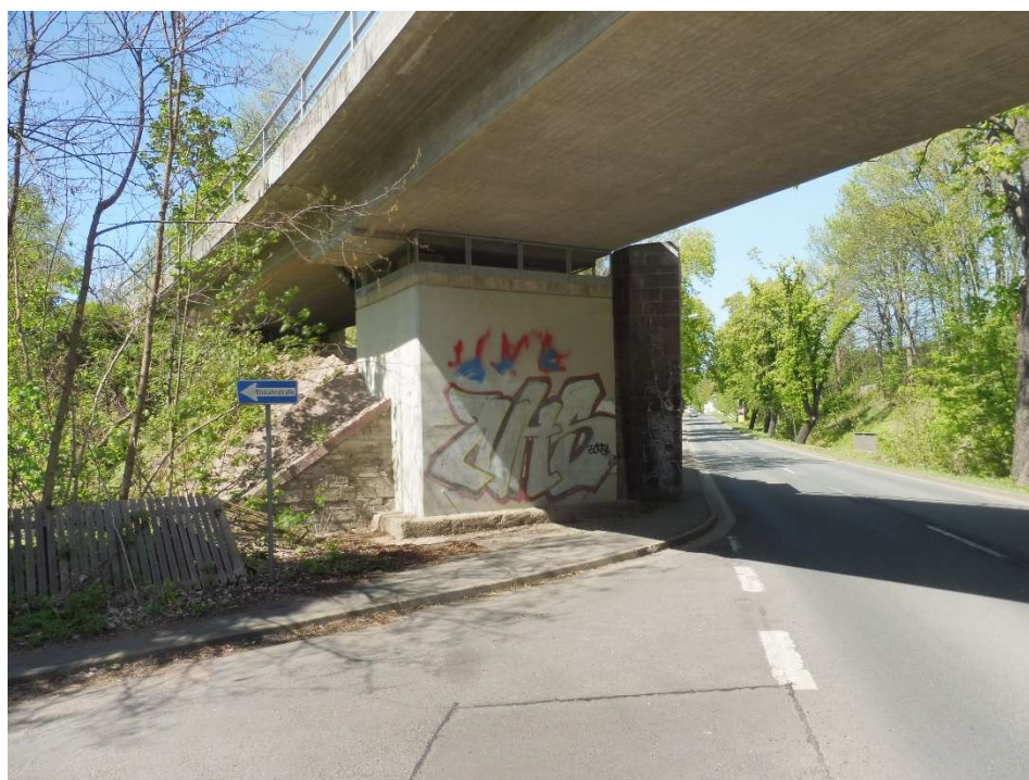
Bild 5: Ansicht hinterer, zweiter Pfeiler und Überbau hinten (Stand: 05.2024)
