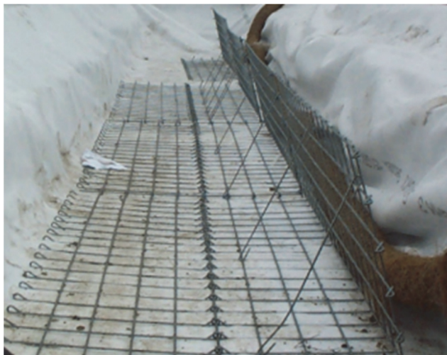
Abb. 8.3: Erdverbundkonstruktion links und Betonschalungselement rechts
