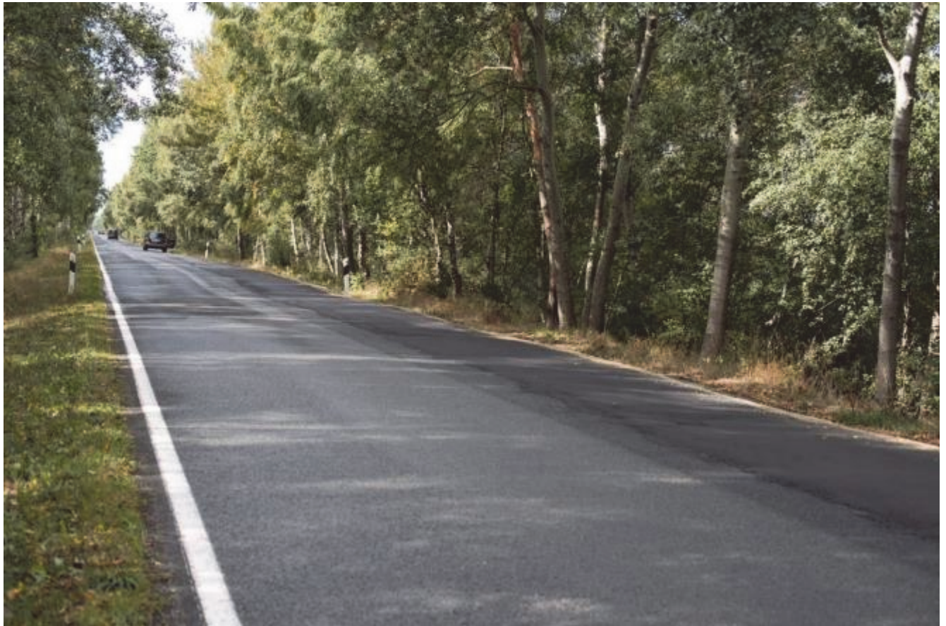
Abb. 1.1: Foto der K347 mit sichtbarer „Wellenbildung“ an der Asphaltoberfläche (Quelle: Region Hannover)
