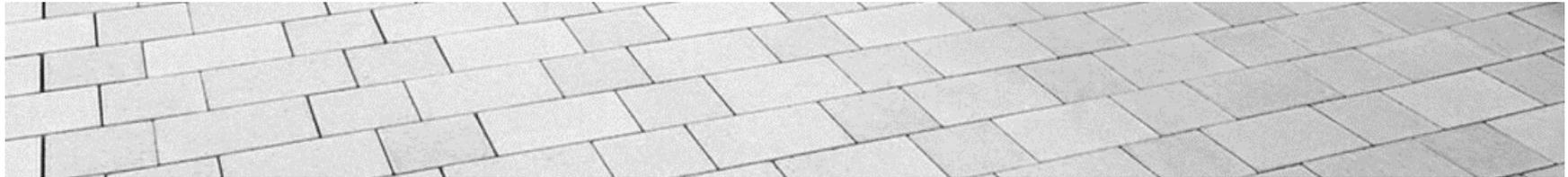
Betonpflasterbelag mit Dränfugen, Kombi- Mehrformat, mind. R 12 - gehwegfreundlicher Belag mit schmalen 6mm-Fugen, verschiebesicher, guter Niederschlagabfluss / Pflaster 2-lagig mit Natursteinvorsatz **Farbe Altweiß**
