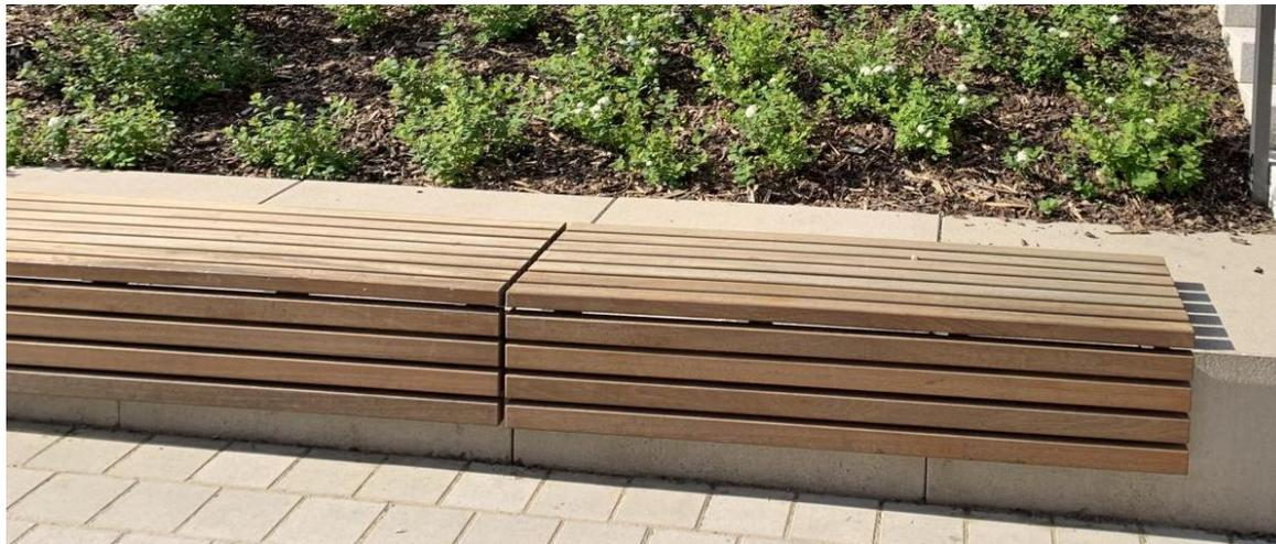
*Sitzauflagen mit Lattung aus Hartholz (Freilichtbühne Stufenanlage)*
