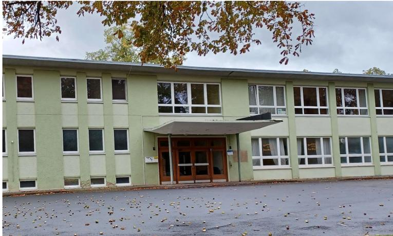
2. Eingangsüberdachung Terrasse aus Stahlbeton, Rückbau Dacheindeckung, einschließlich 1 Stützen (Stahl), Fundamente aus Beton oder Stahlbeton. Rückbau Dachüberstand am Anbau.
