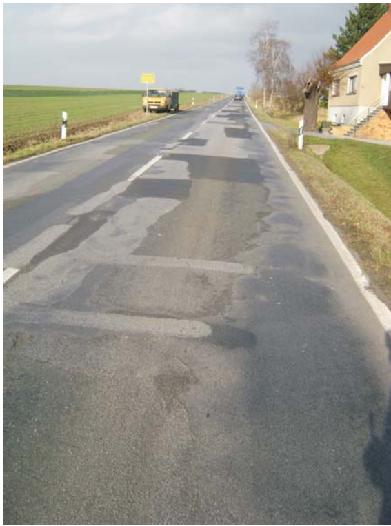
Foto Nr. 1 (km 0-030 - Flickstellen, Ausbesserungen)
