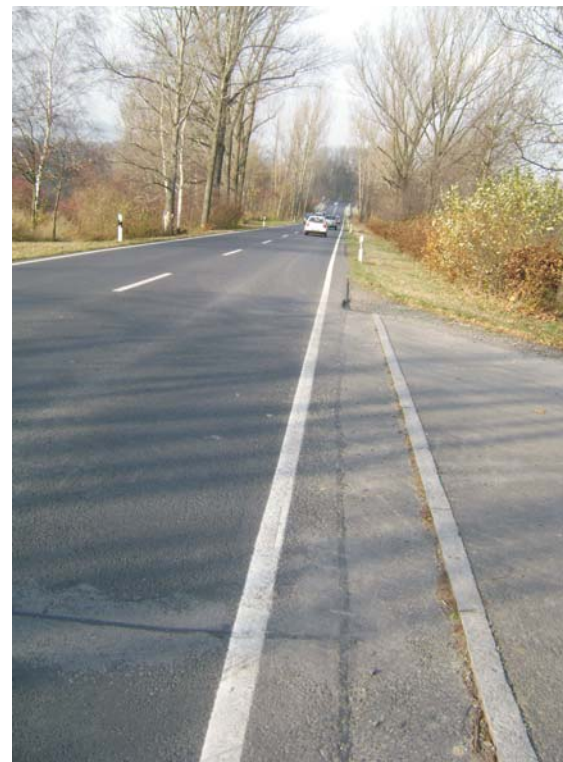
Foto Nr. 5 (ab km 1+350 - erneuerte Fahrbahnoberfläche)
