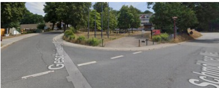
Bild 1: Baustelleneinfahrt Platz des Volkes (Quelle: Google maps)
