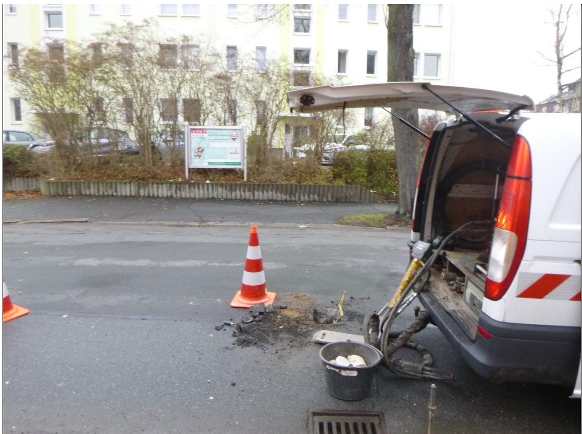
Aufbruch (A) 102 – Ansicht Aufbruchmaterial
