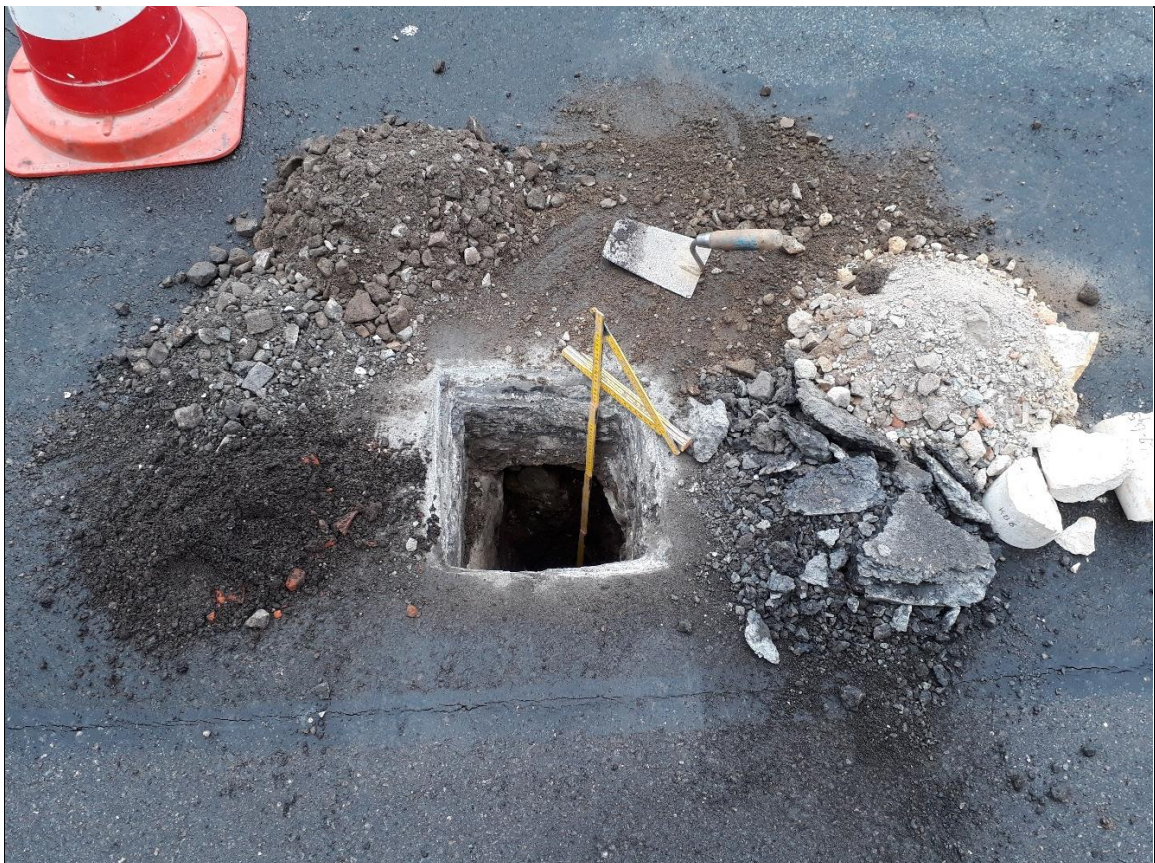
Aufbruch (A) 101 – Ansicht Aufbruchmaterial
