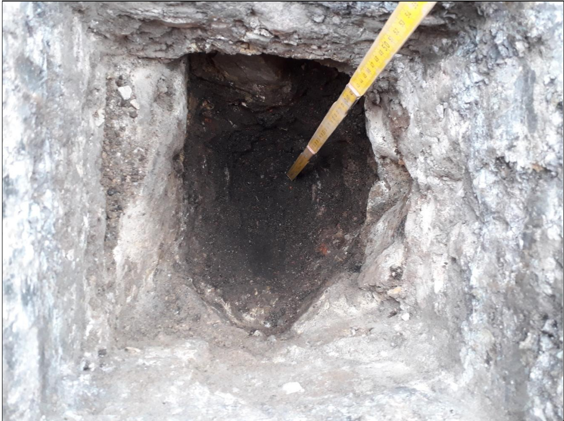
Aufbruch (A) 101 – Innenansicht Aufbruch
