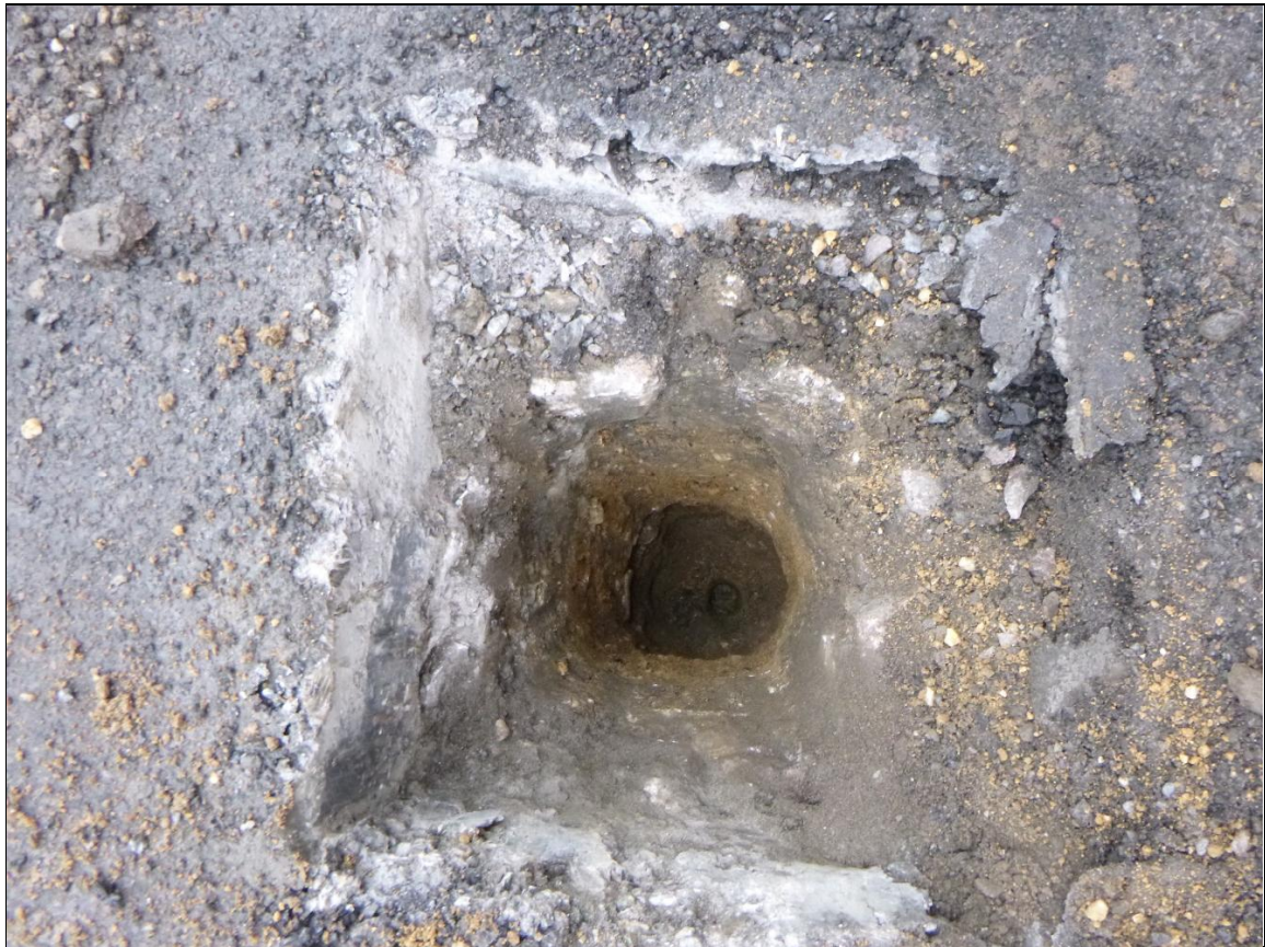
Aufbruch (A) 102 – Innenansicht Aufbruch
