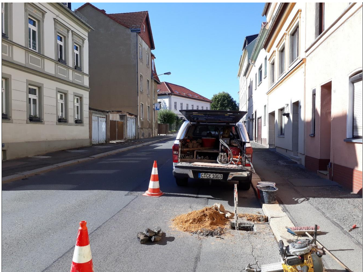
Aufbruch und Rammkernsondierung (A/RKS) 2 – Ansatzpunkt
