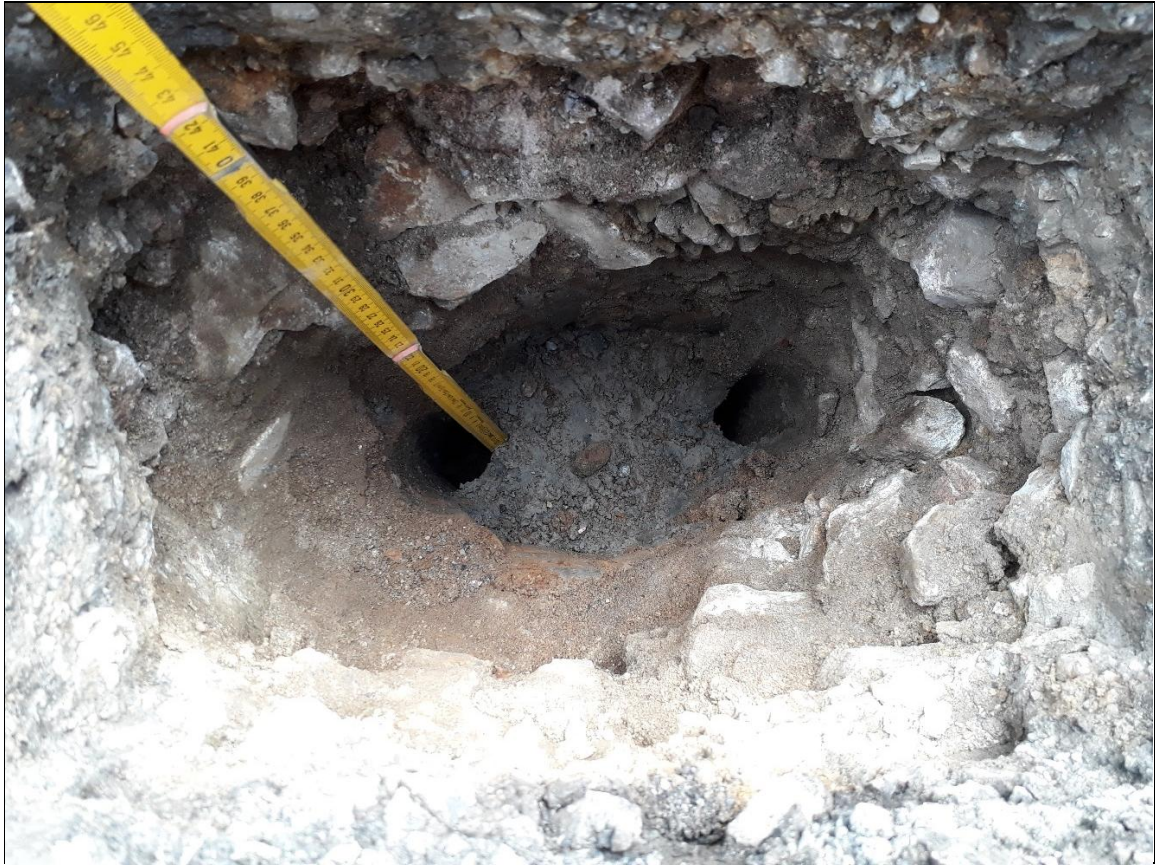
Aufbruch und Rammkernsondierung (A/RKS) 6 – Innenansicht Aufbruch
