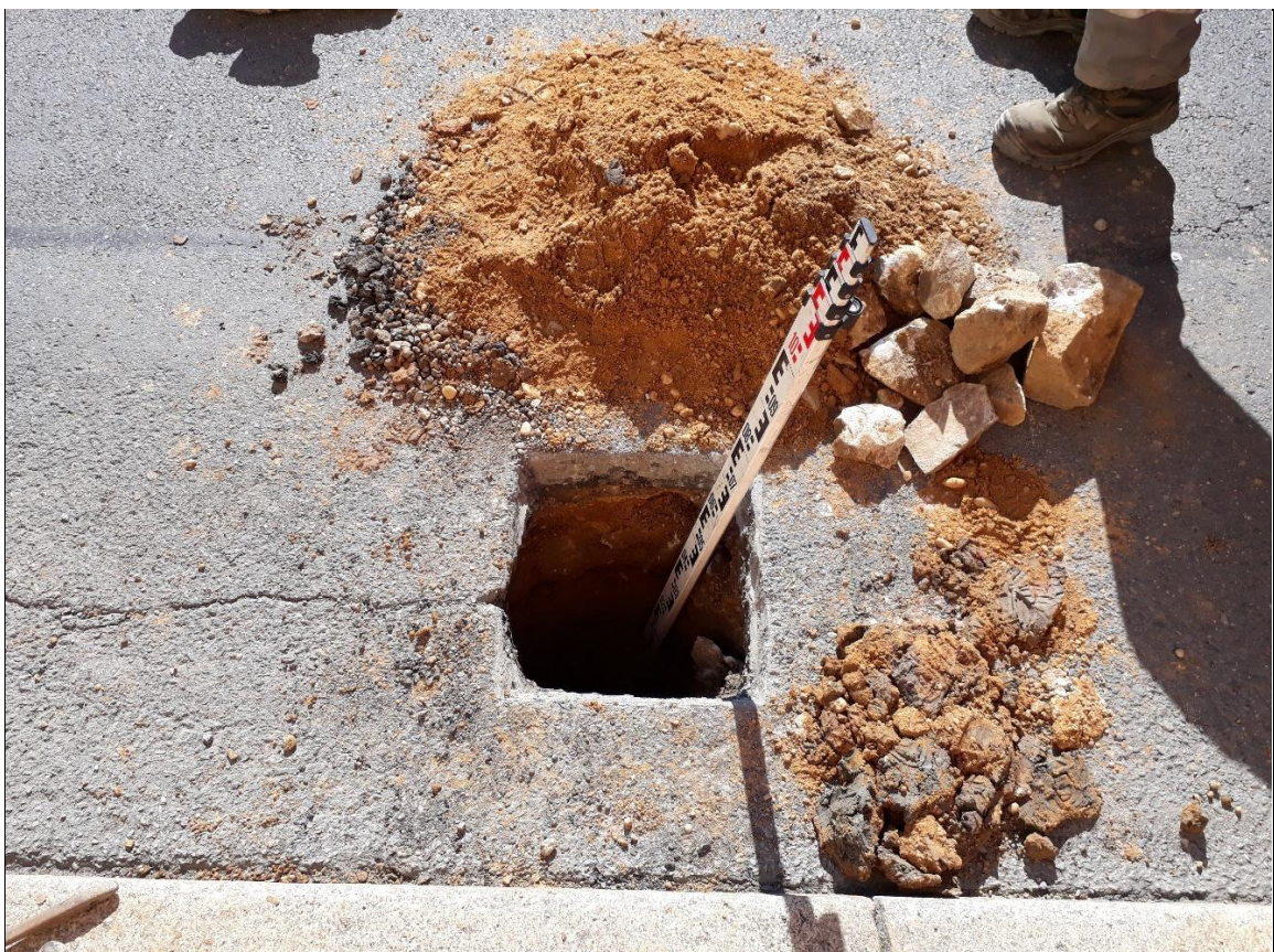
Aufbruch und Rammkernsondierung (A/RKS) 2 – Ansicht Aufbruchmaterial
