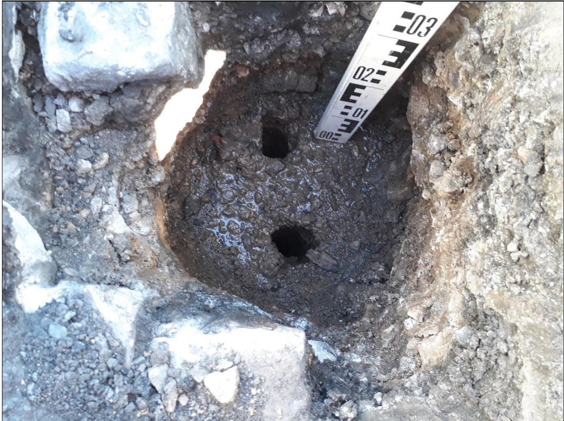
Aufbruch und Rammkernsondierung (A/RKS) 4 – Innenansicht Aufbruch
