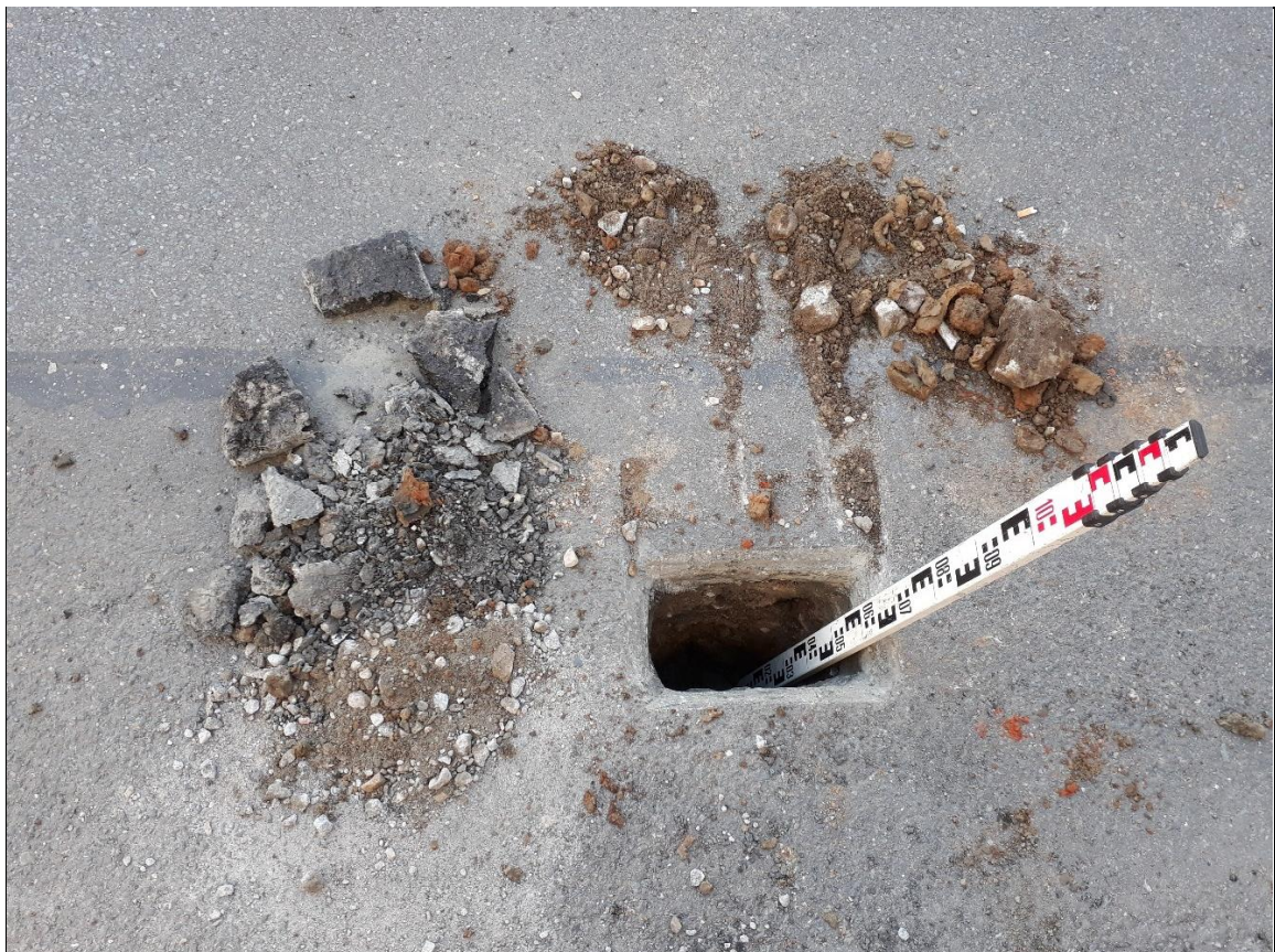
Aufbruch und Rammkernsondierung (A/RKS) 1 – Ansicht Aufbruchmaterial
