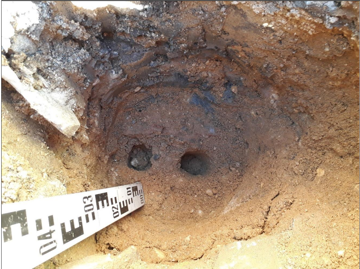
Aufbruch und Rammkernsondierung (A/RKS) 2 – Innenansicht Aufbruch
