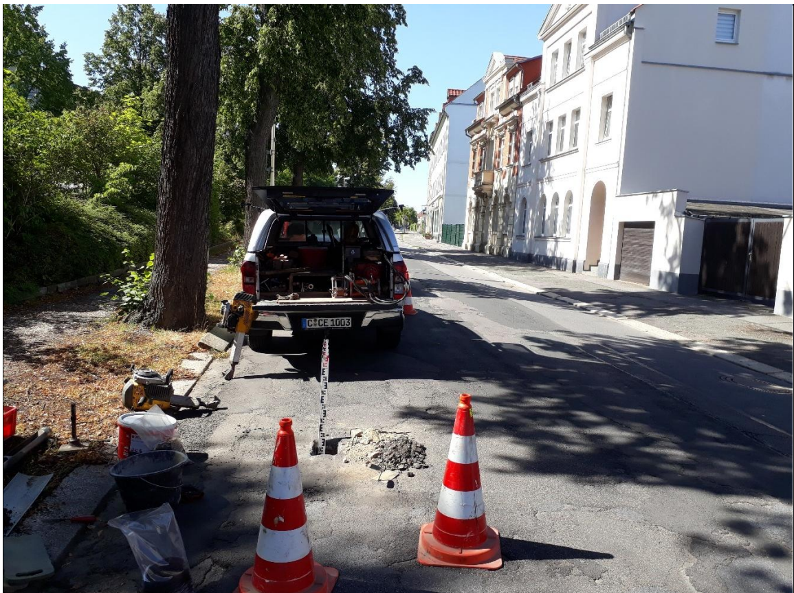
Aufbruch und Rammkernsondierung (A/RKS) 3 – Ansatzpunkt
