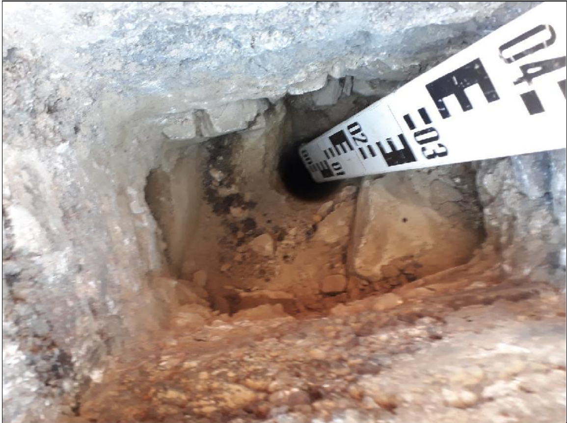
Aufbruch und Rammkernsondierung (A/RKS) 3 – Innenansicht Aufbruch
