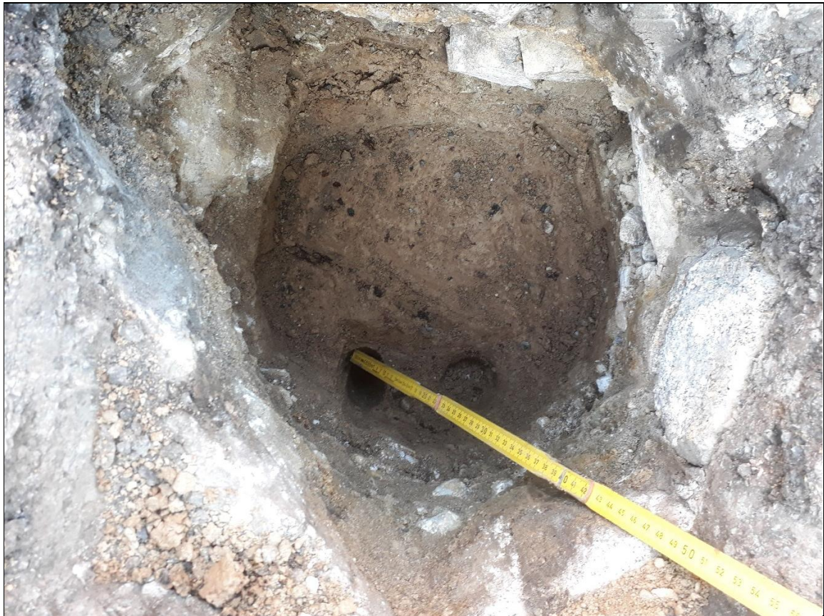
Aufbruch und Rammkernsondierung (A/RKS) 5 – Innenansicht Aufbruch
