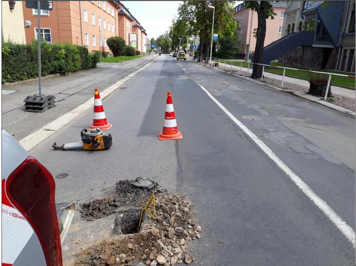
Aufbruch und Rammkernsondierung (A/RKS) 6 – Ansatzpunkt
