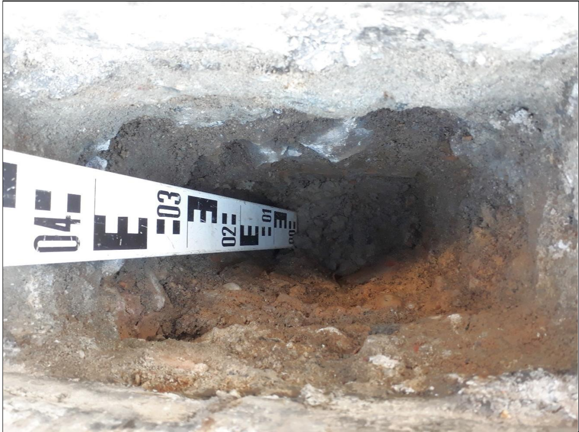
Aufbruch und Rammkernsondierung (A/RKS) 1 – Innenansicht Aufbruch
