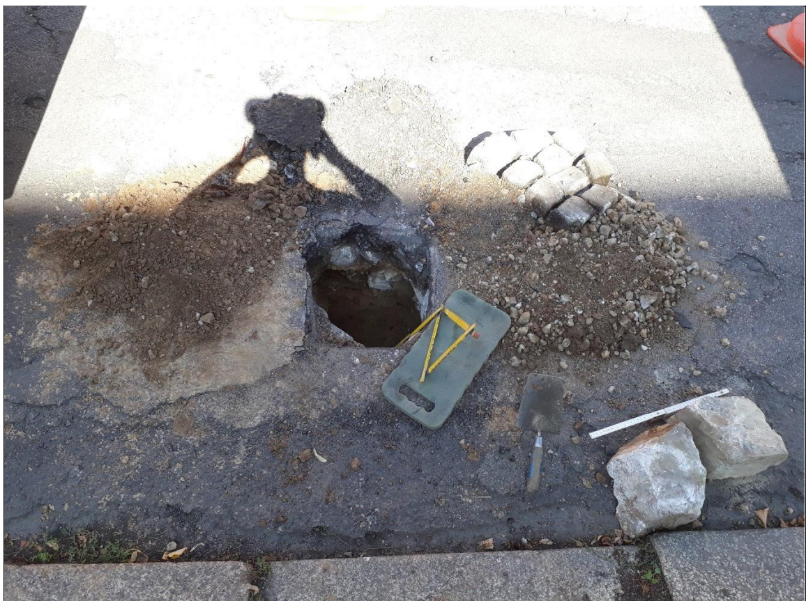
Aufbruch und Rammkernsondierung (A/RKS) 5 – Ansicht Aufbruchmaterial
