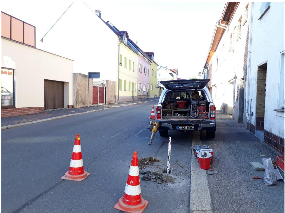
Aufbruch und Rammkernsondierung (A/RKS) 1 – Ansatzpunkt
