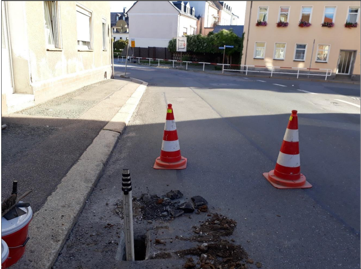
Aufbruch und Rammkernsondierung (A/RKS) 1 – Ansatzpunkt
