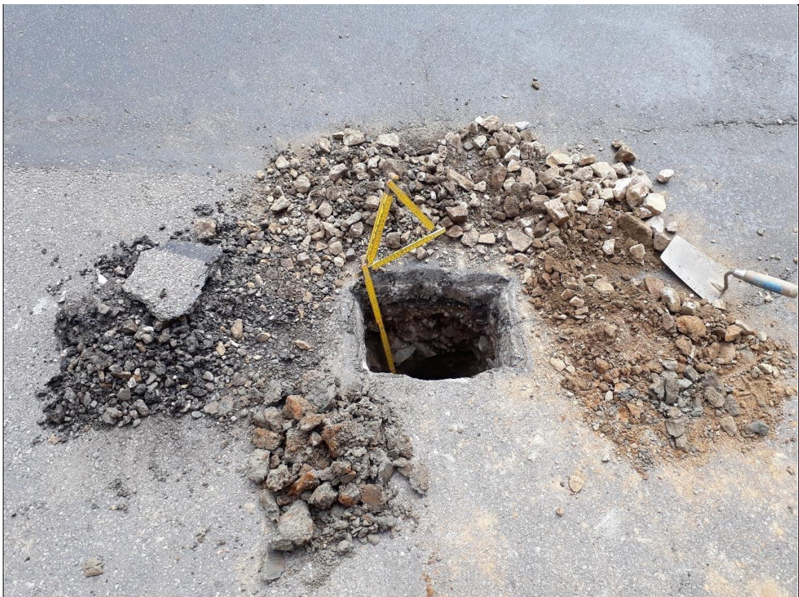
Aufbruch und Rammkernsondierung (A/RKS) 6 – Ansicht Aufbruchmaterial
