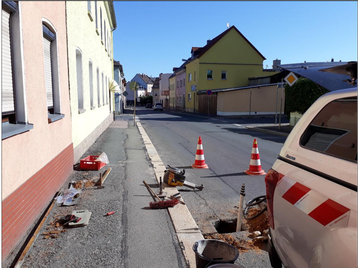
Aufbruch und Rammkernsondierung (A/RKS) 2 – Ansatzpunkt
