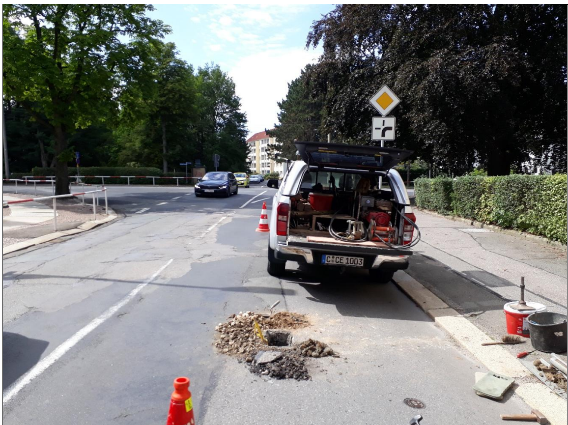
Aufbruch und Rammkernsondierung (A/RKS) 6 – Ansatzpunkt
