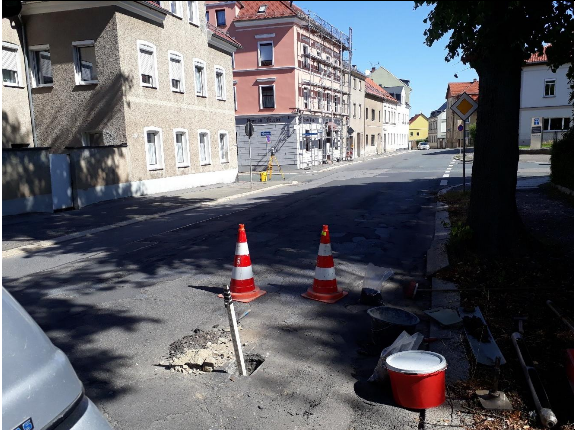
Aufbruch und Rammkernsondierung (A/RKS) 3 – Ansatzpunkt
