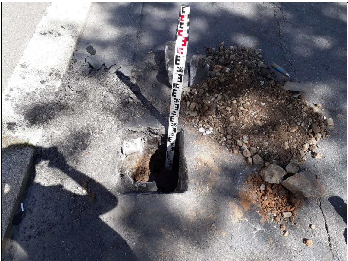
Aufbruch und Rammkernsondierung (A/RKS) 4 – Ansicht Aufbruchmaterial
