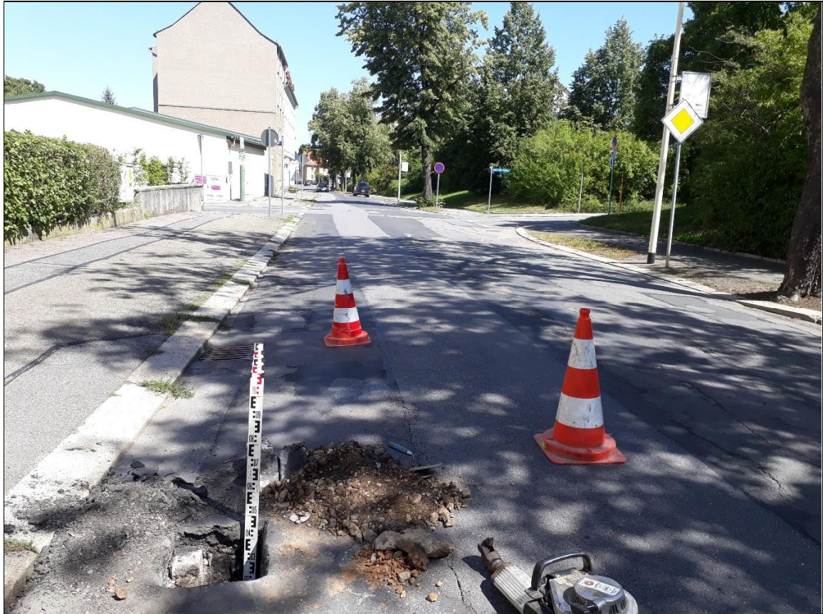
Aufbruch und Rammkernsondierung (A/RKS) 4 – Ansatzpunkt
