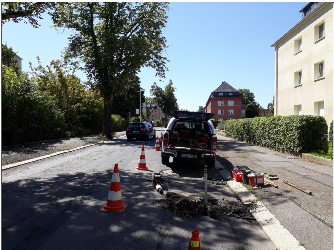
Aufbruch und Rammkernsondierung (A/RKS) 4 – Ansatzpunkt
