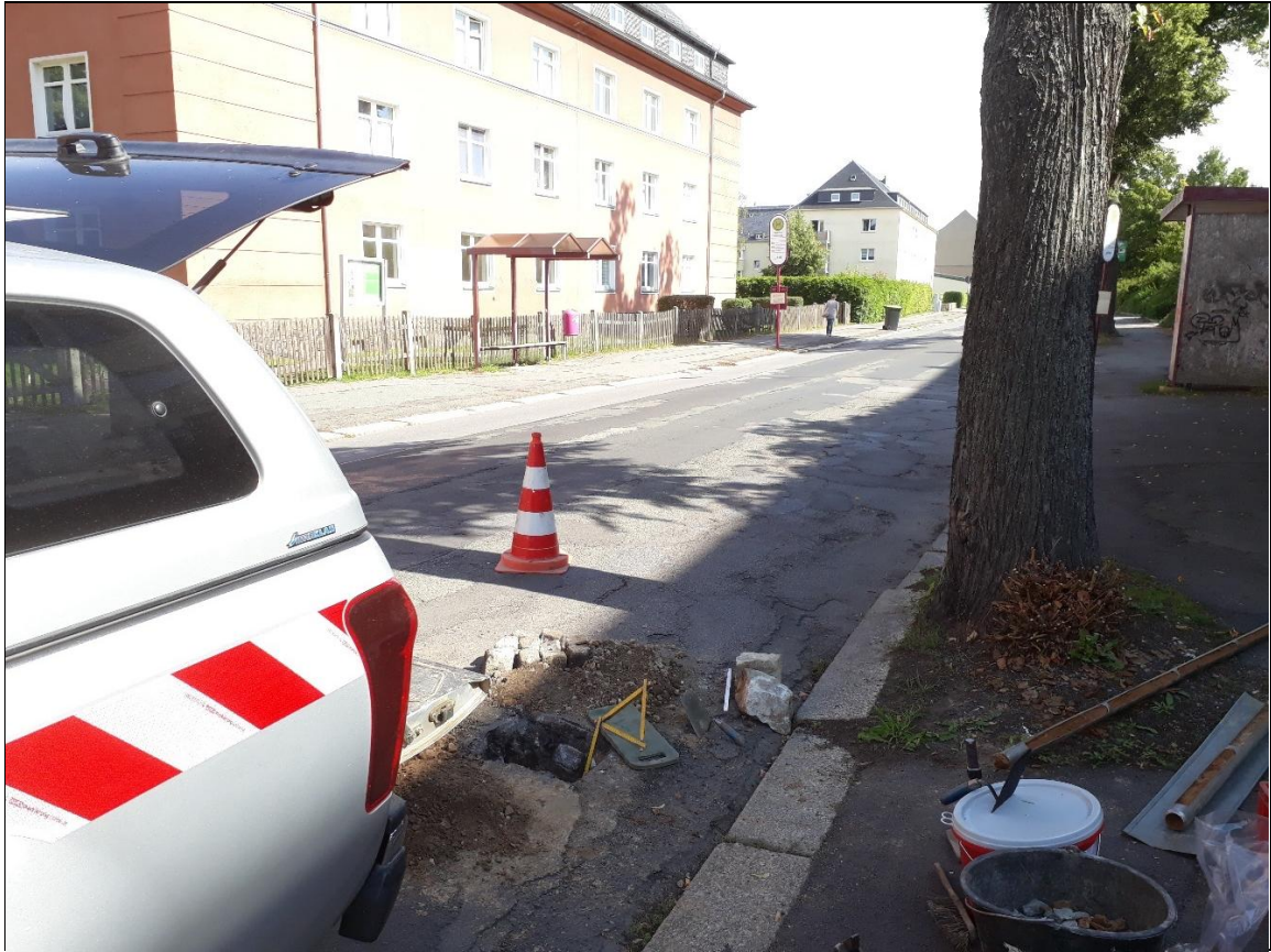
Aufbruch und Rammkernsondierung (A/RKS) 5 – Ansatzpunkt
