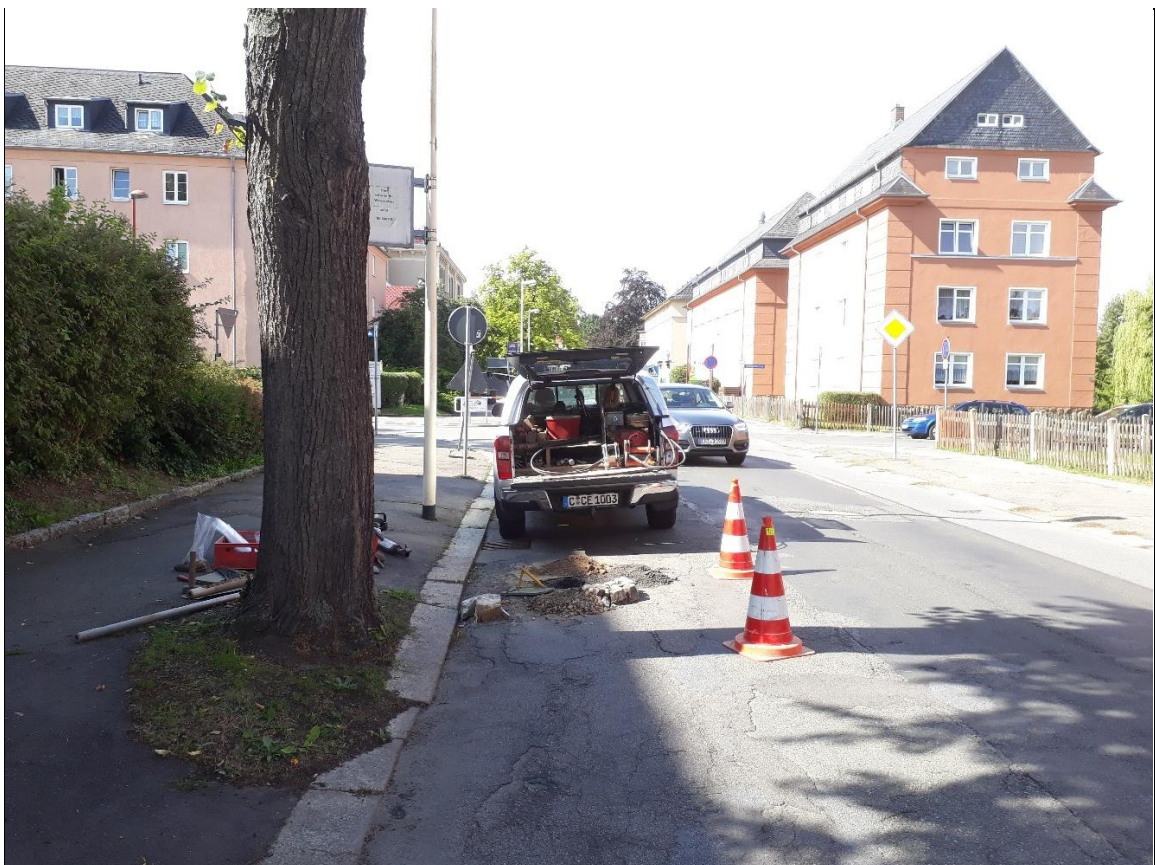
Aufbruch und Rammkernsondierung (A/RKS) 5 – Ansatzpunkt
