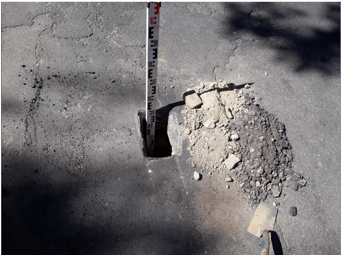
Aufbruch und Rammkernsondierung (A/RKS) 3 – Ansicht Aufbruchmaterial
