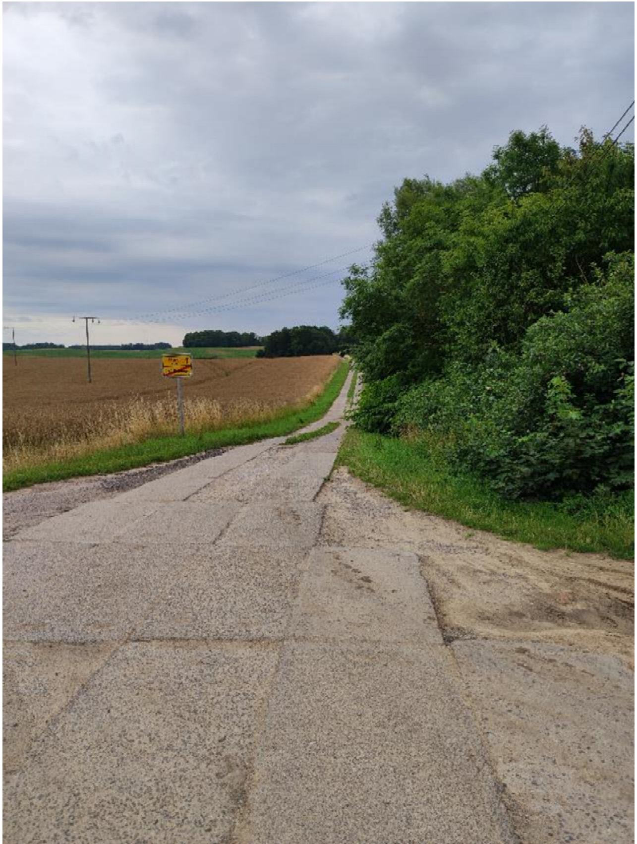
Foto 1: Die Zufahrtsstraße aus Richtung Horst
